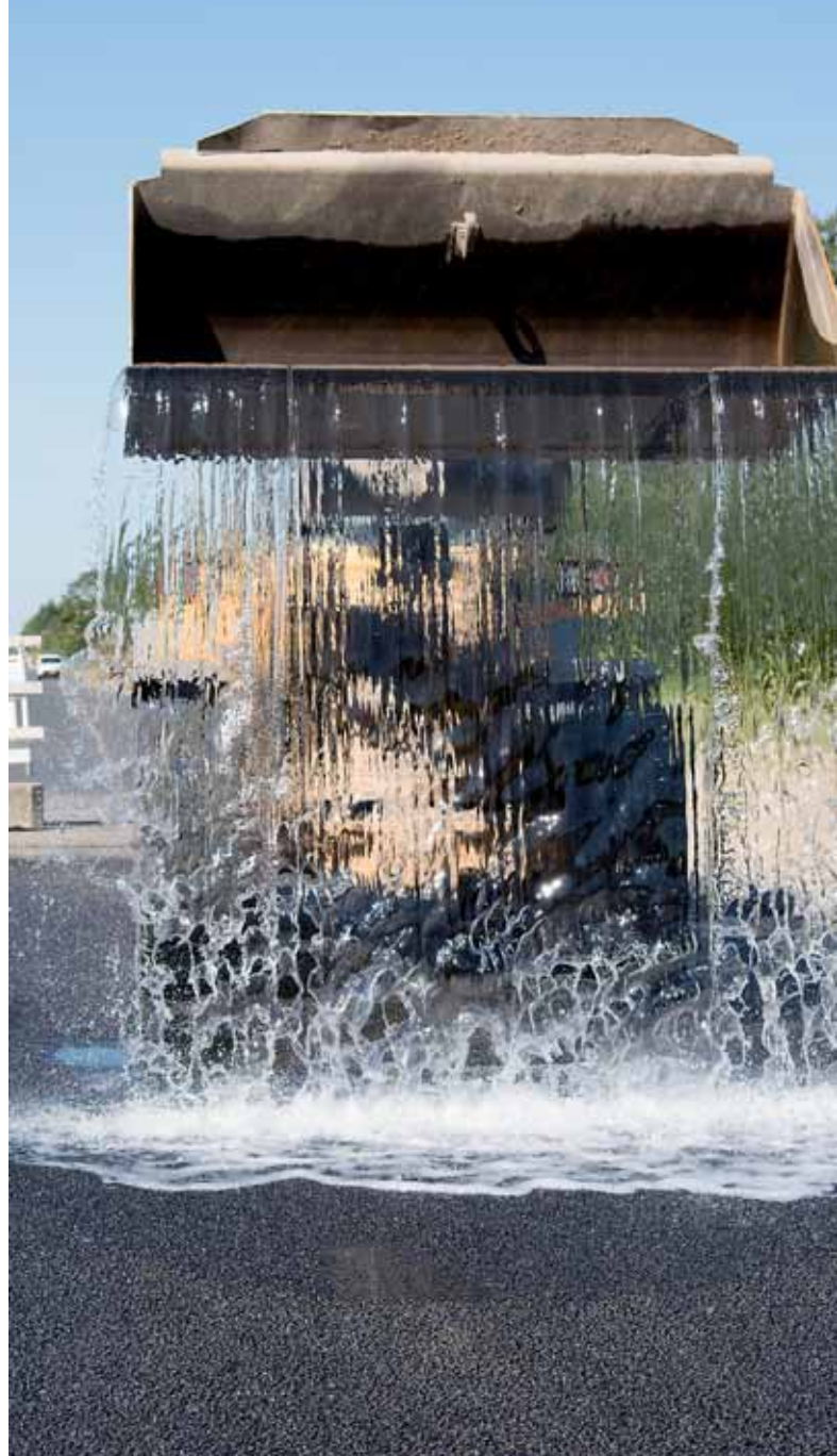
Lufthavnsvejen i Aalborg er anlagt som en permeabel befæstelse med Drænstabil og drænasfalt. Foto: Michael Brask, NCC.
