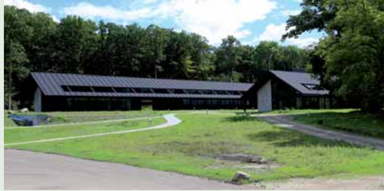
Det nye byggeri ligger smukt i skovbrynet ved Kalø Vig. Og med naturpræget friareal helt op til facaderne. Foto: Max Steinar.
