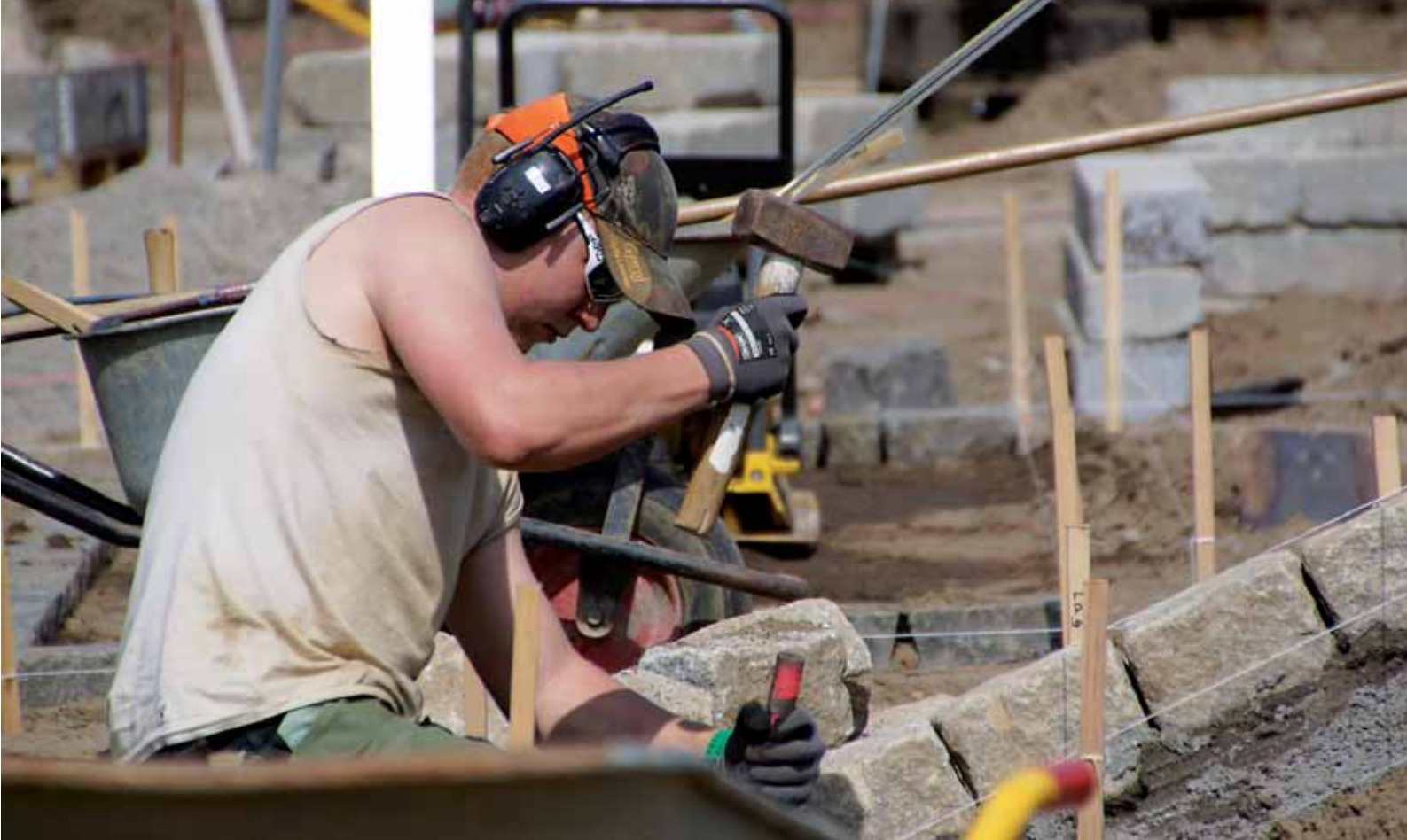
Der sker ikke mange ulykker blandt landets anlægsgartnerelever. Heldigvis. Flere parter mener dog at skolerne skal være bedre til at opdrage eleverne til altid at udføre arbejdet arbejdsmiljømæssigt korrekt. Her ser det dog fint ud. Foto: Jordbrugets Uddannelsescenter Århus.
