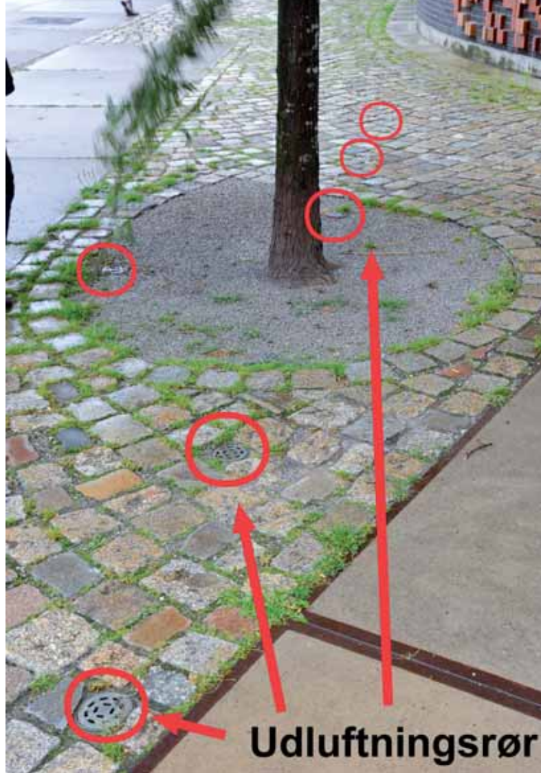
En meget vital Gleditsia triacanthos på kajen mod Magellanterrasserne. Udluftningshullerne i belægningen indikerer en større og aflang underjordisk plantegrube - givetvis opbygget med FLL-substrat type 2.
