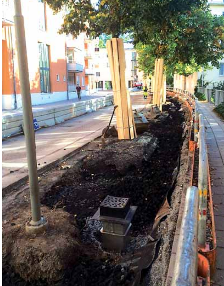
Metoden kan også bruges til eksisterende træer og derved give dem en ny chance for at udvikle sig. Den eksisterende jord suges forsigtigt ud rundt om træerne. Fotos: Stockholms stad, Trafikkontoret.
