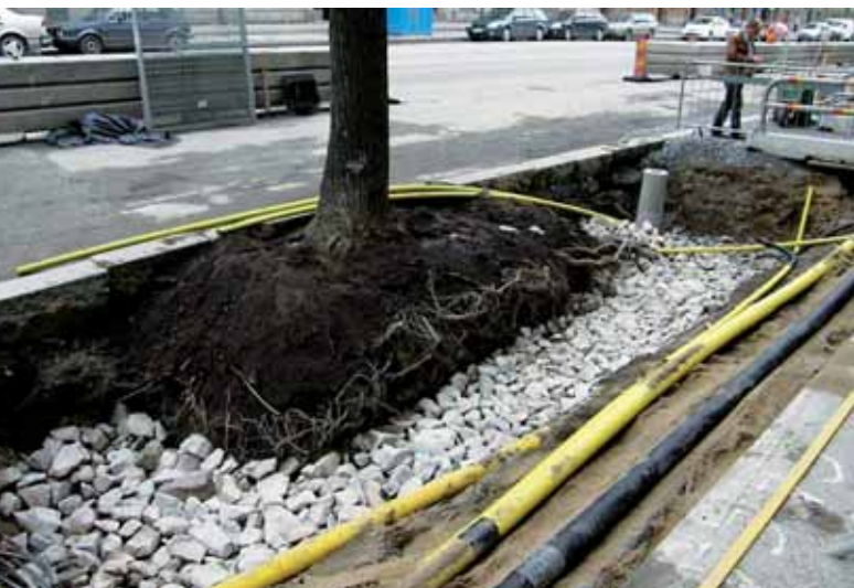
Stockholmsystemet. Udgravningen fyldes lagvist op med et stenskelet der mættes med biokul der produceres af grønt affald. Det er især denne teknik der er svær. Fotos: Stockholms stad, Trafikkontoret.
