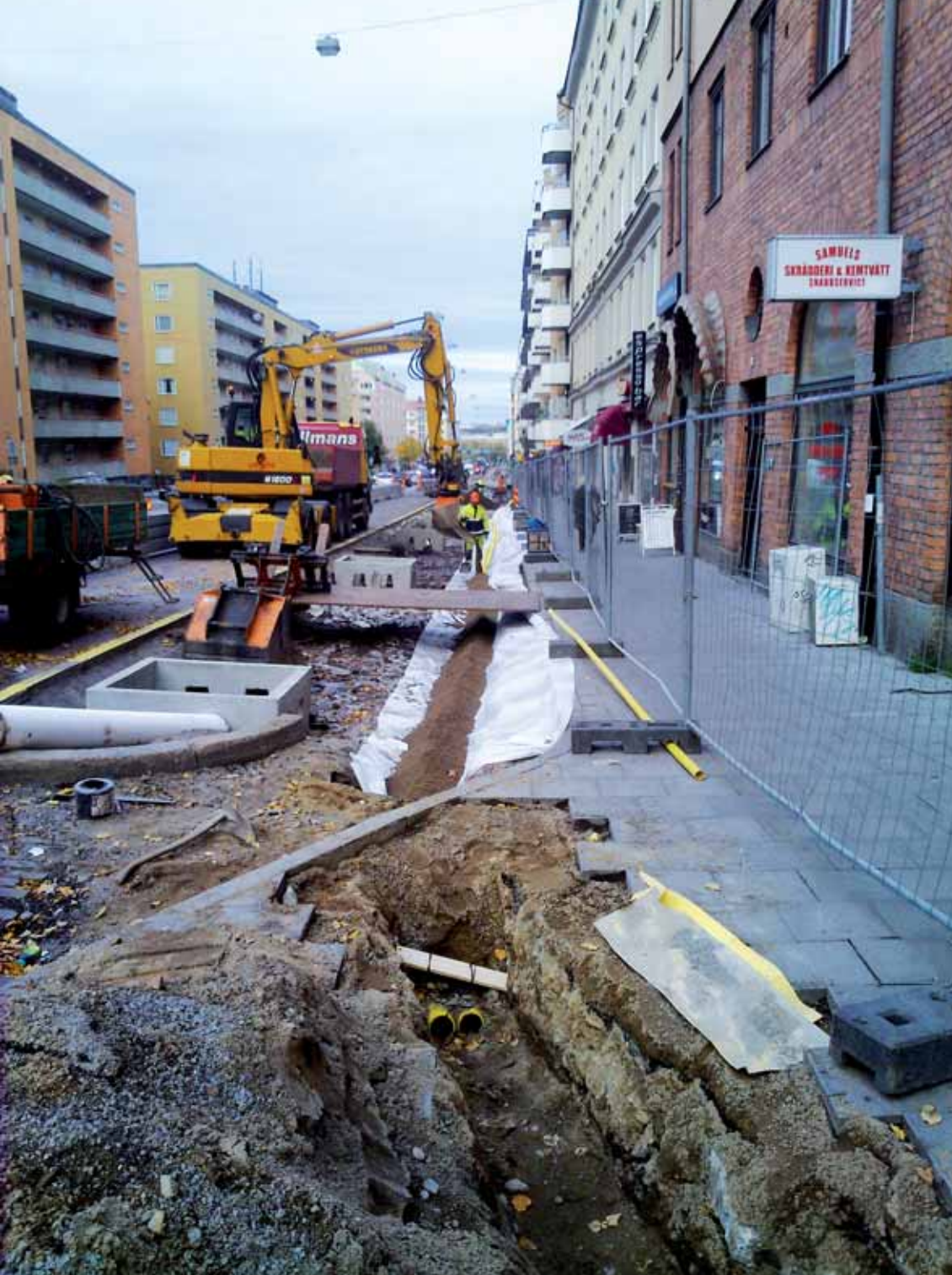
Træplantning i Stockholm med sammenhængende bede af skeletjord. Bedene modtager overfladevand, men mest fra tage og fortov. Foto: Stockholm stad, Trafikkontoret.
