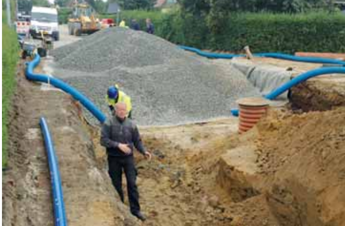
Porskærvej i Galten er en af de veje der etableres med NCC PermaVej som en del af en samlet klimasikring. Foto: NCC.
