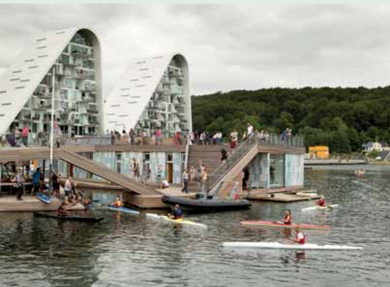
Friluftsliv ved byggeriet 'Bølgen' ved Vejle Fjord. Foto: Nils Rosenvold.
