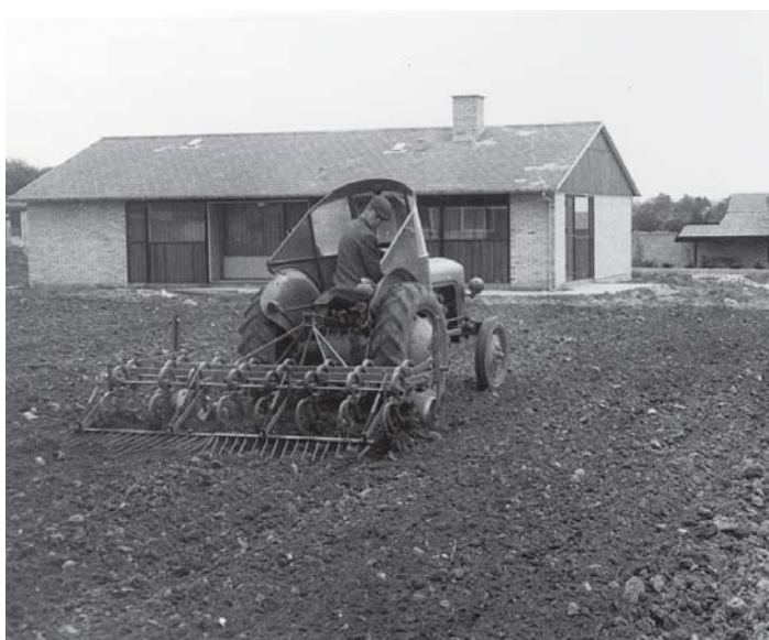
Parcelhusbyggeriet var en del af den voldsomme byudvikling i 60'erne. Her er anlægsgartneren gået i gang med jordbehandlingen med tidens traditionelle landbrugsredskaber: en fjedertandsharve med strigle trukket af en Massey Ferguson 135. Fra 1965.
