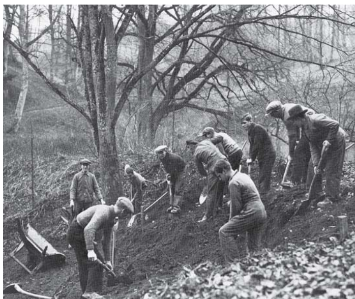
I 1930'ernes arbejdsløshed blev der givet tilskud til 'nødhjælpsarbejder'. Da arbejdsgiverne ikke måtte tjene på dem, kom de mest til at omfatte vejarbejder, anlæg af sportspladser, naturfredningsopgaver og lignende. Her en reguleringsopgave i Risskov, Århus, 1934. Fra 'Arbejdsmandens historie gennem 100 år'. 2
