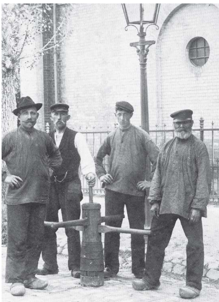
Stødning af belægningsoverflader udførtes dengang overalt med brolæggerjomfru. Det gør man trods alt ikke mere. Stødning var arbejdsmandsarbejde, mens selve brolægningen udførtes af uddannede brolæggere. Her er fire mand klar til at støde jomfruen foran Ceres bryggeriet i Århus. Ca. 1900. Fra 'Arbejdsmandens historie i 100 år'. 3
