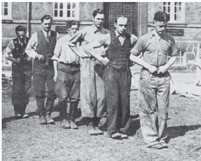
„Trædning af en græsplæne før såning - et arbejde, som vanskeligt kan mekaniseres,“ skrev anlægsgartner Victor Hansen i 1952.
