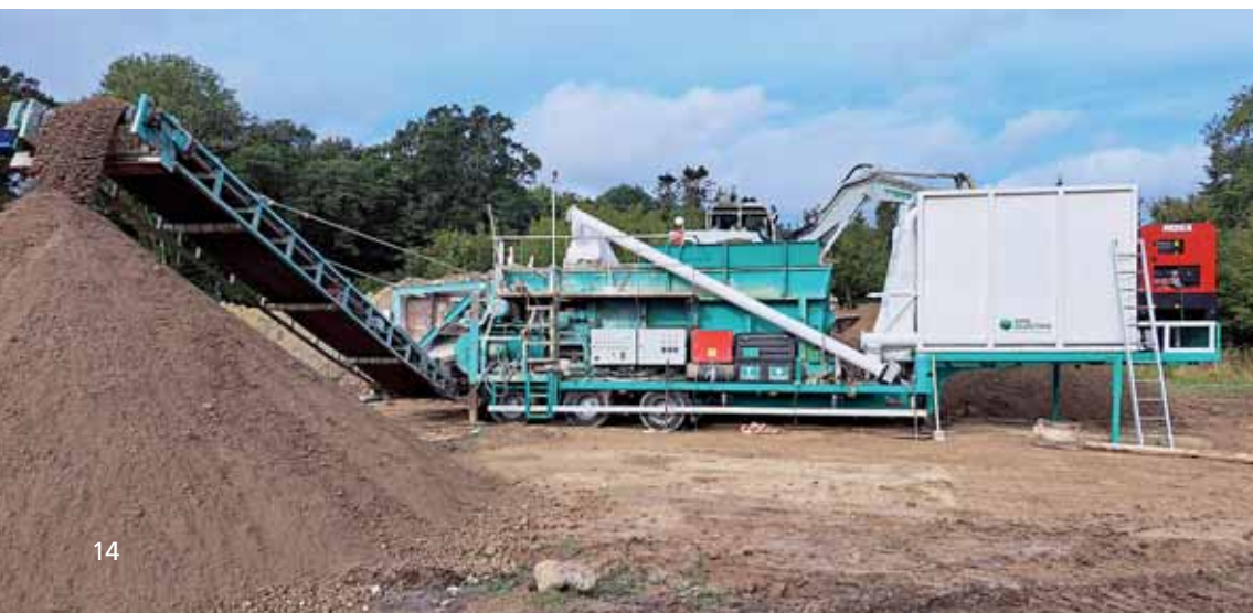
• Stabilisering af lerjord med kalk på et mobilt anlæg. Metoden er relevant til overskudsjord eller hvor der ikke er plads til at blande på stedet. Efter stabilisering kan jorden indbygges. Foto: Finn Andersen.
