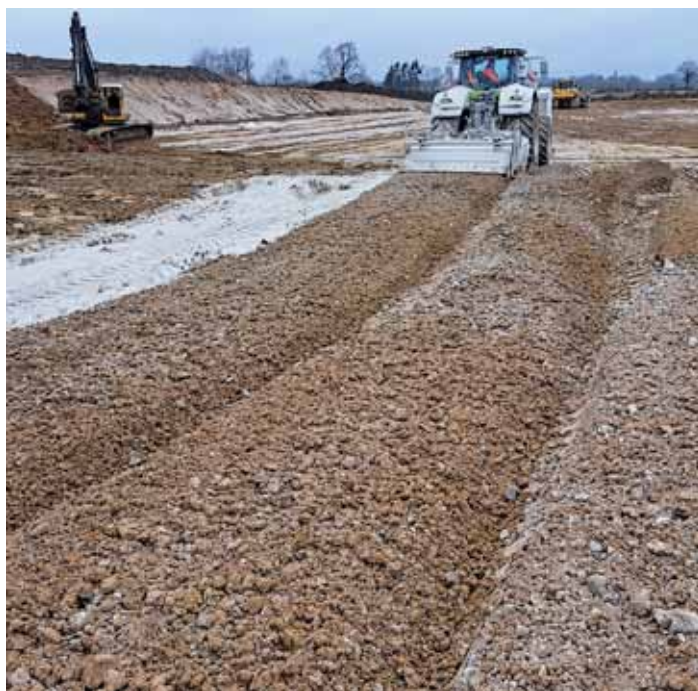
• Stabiliseringsproces for mindre projekter. En traktor med fræser blander kalken ned i jorden. Foto: Finn Andersen.
