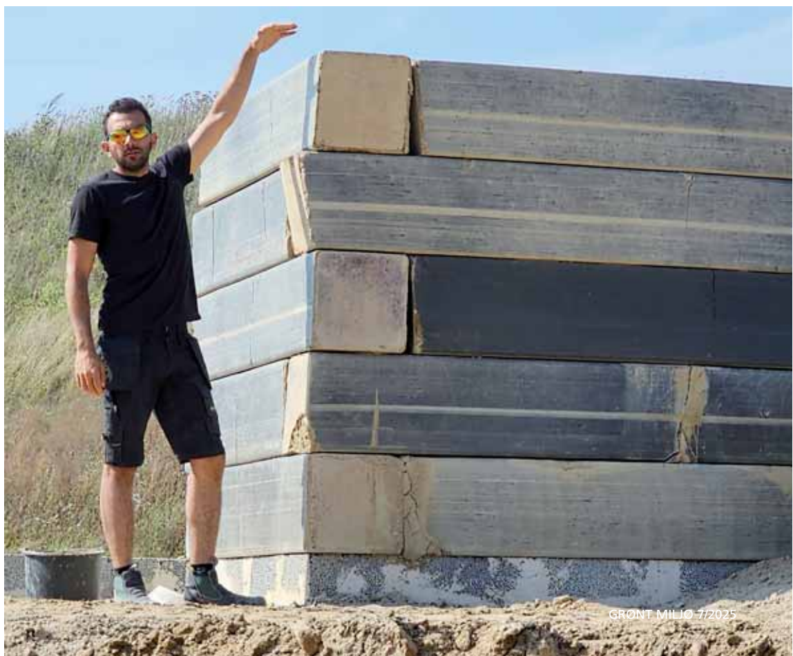
• Teststøjskærmen er her opført af komprimerede lerjordselementer i godt 2 meters højde. Foto: Niels Brix.
