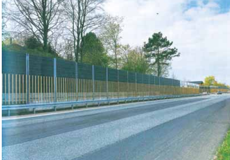
• I Kregme er der opsat en skærm der er 4 meter høj og op til 1 km lang.
