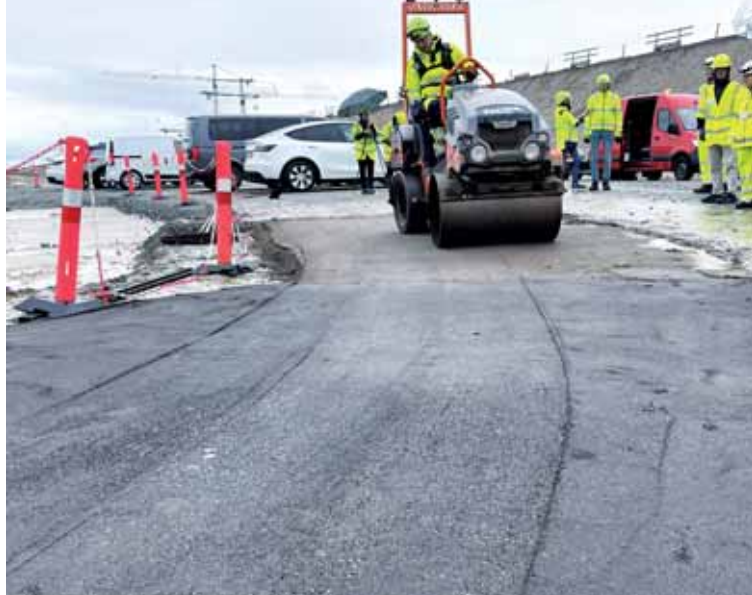
• Afprøvningen af asfalten med svampebindemiddel. Foto: Visibuilt.
