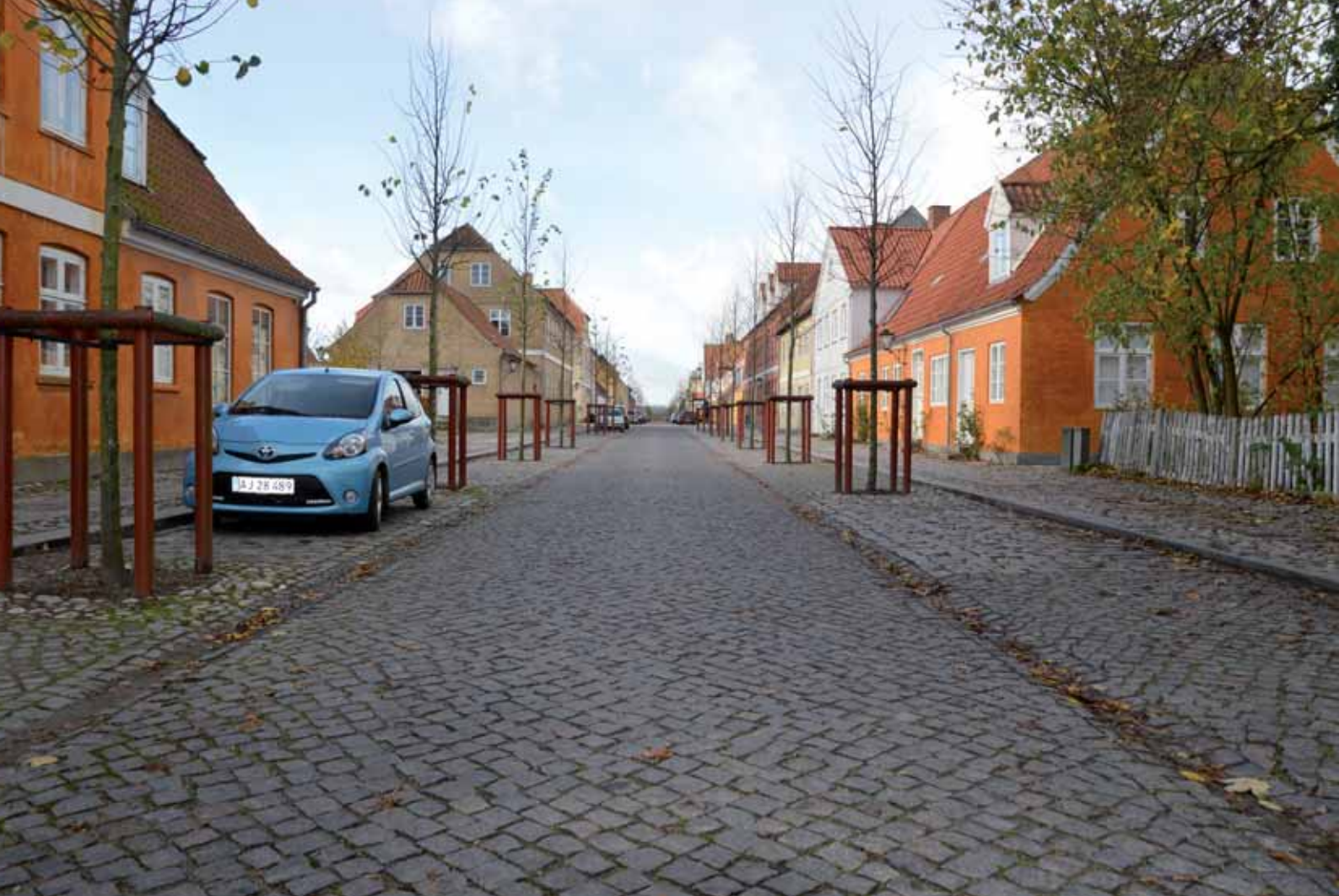
Nye kejserlind med rødder i 'stratacells' og belægning af chaussésten i krydsforbandt. Foto: Thomas Thinghuus.
