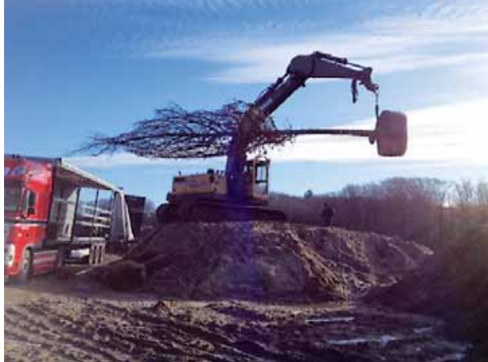
Der måttet etableres en jordhøj for at gravemaskinen kunne komme til at læsse træerne. Rebene er fastgjort så træet hænger vandret.
