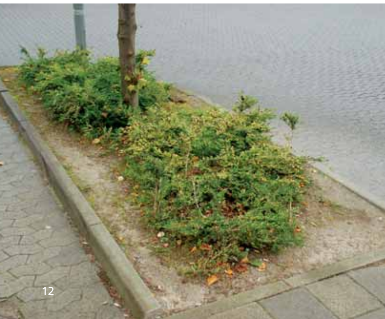
Figur 2. Plantegruber langs veje og p-pladser er belastet af færdsel og bør opbygges med strukturstabile substrater, f.eks. efter FLL-standardens.
