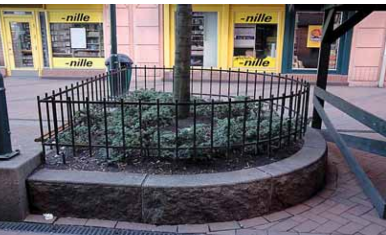
Figur 1. Rodrummet er beskyttet mod færdsel. Her kan man anvende en jord der er optimal for træet uden at tænke på at jorden komprimeres.
