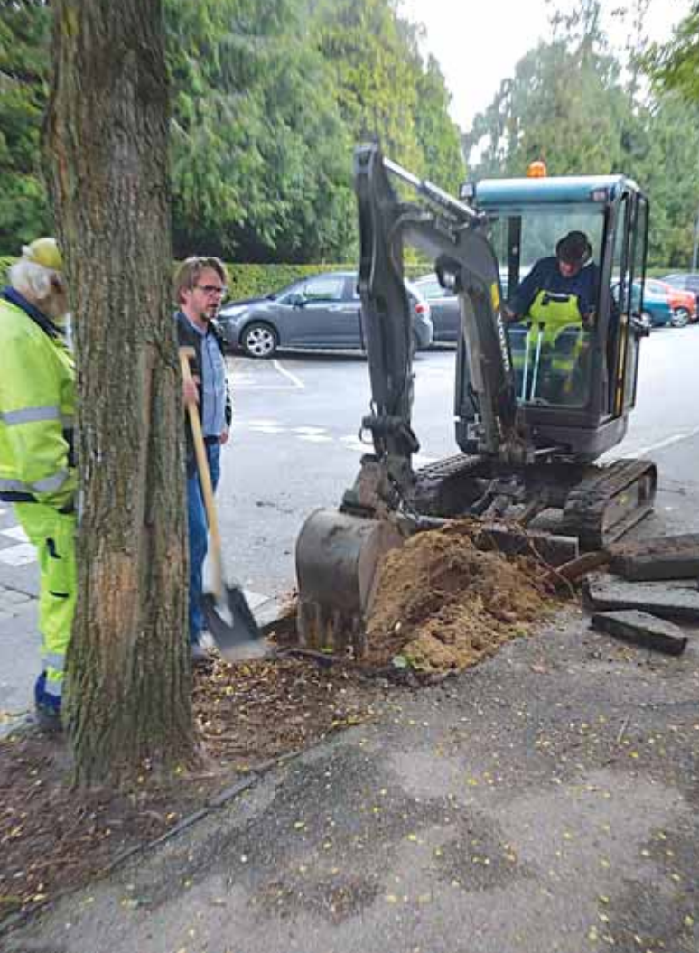
Fig. 9. En prøvegravning kan vise hvor god underjorden er til rodvækst.
