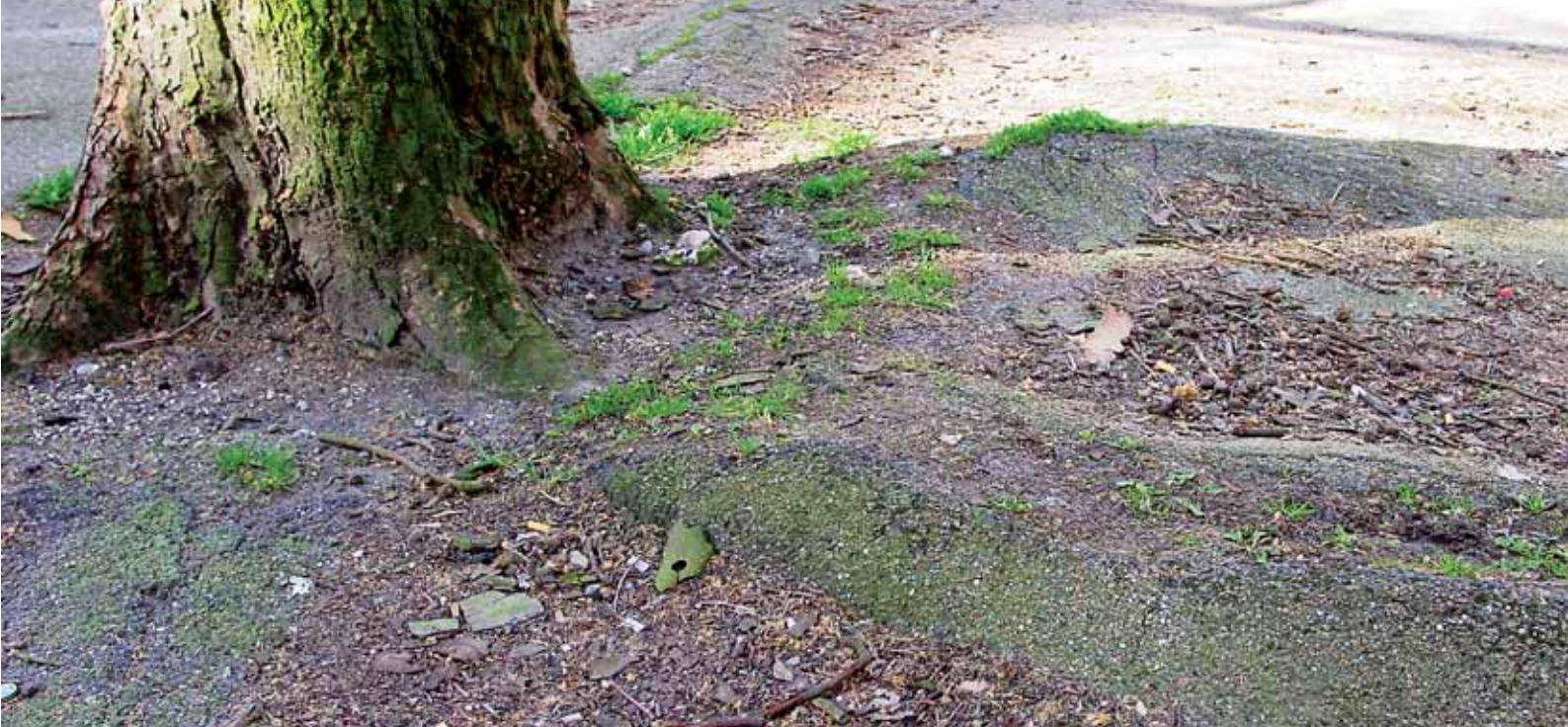
Figur 4: Rodvenlige substrater og dybe plantegruber kan ikke i sig selv helt forhindre, men i høj grad modvirke rodvækst under belægningerne.
