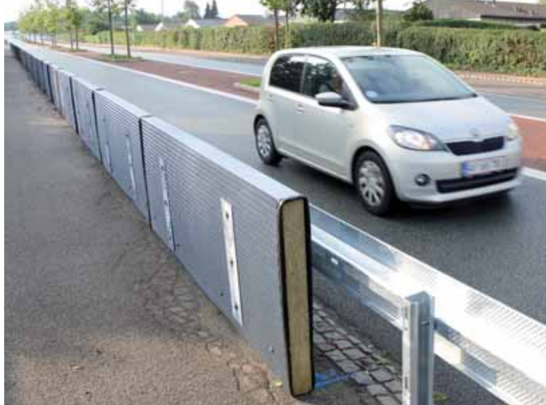
Nag 1 har døbt støj- og autoværnet EasyRail. Foto: Nag 1. gate21.dk.
