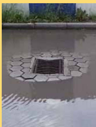
3. Det er ikke altid let at skabe det rette fald på belægningen. Det er til gengæld vigtigt.
