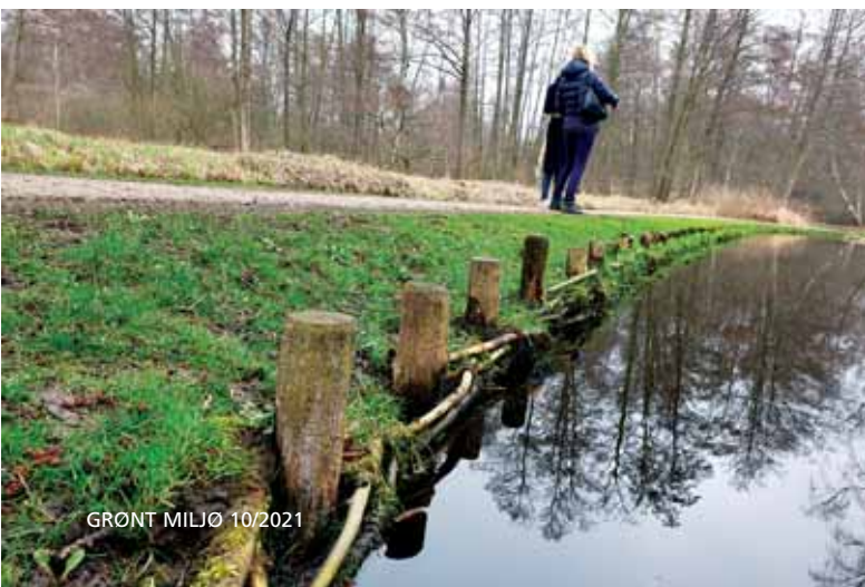
På Frederiksborg Slot er der på billedet til venstre anvendt pileflet langs kanten af stien. Den samme metode vil blive anvendt i Move Green Lab for at sikre at folk med bevægelseshandicap kan komme helt ned til vandet i passagen på billedet til højre. Foto: Ulrika K. Stigsdotter.
