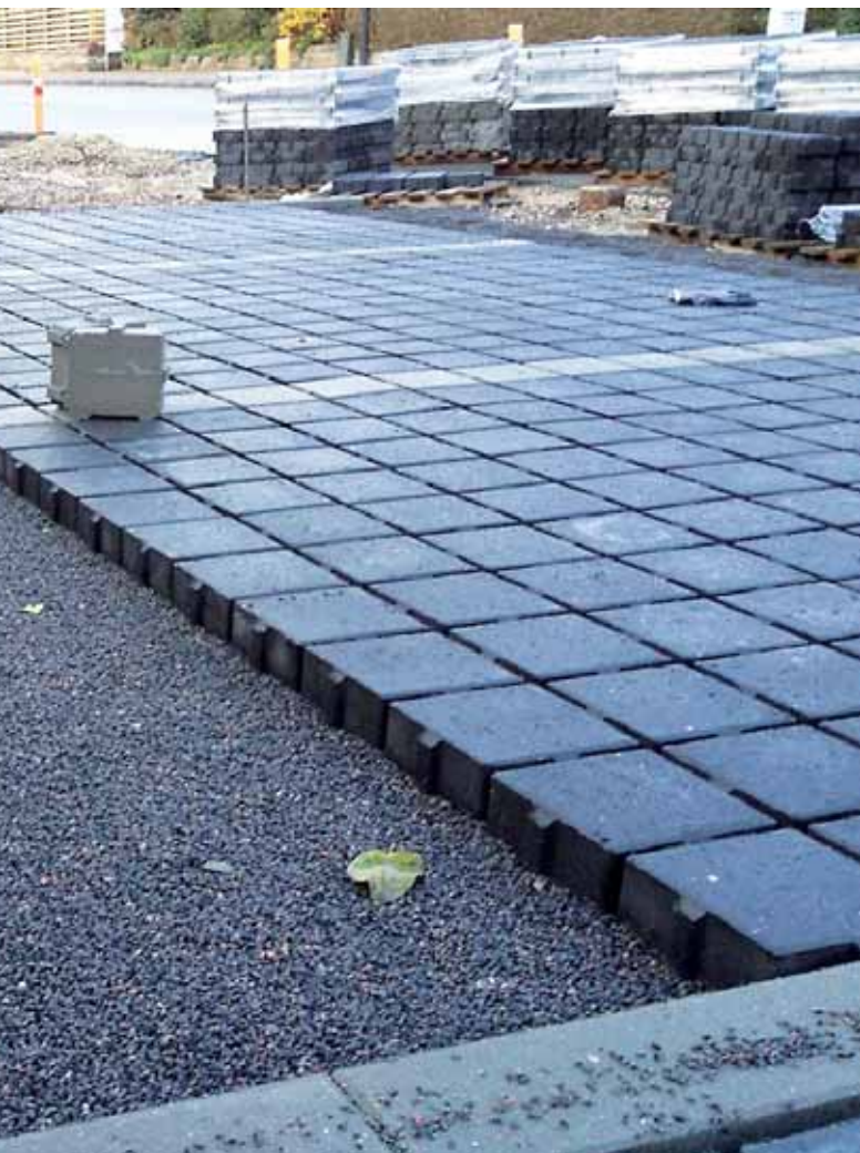
Nederst: Opbygning af permeabel befæstelse med NCC's 'DrænStabil' og 'DrænAf' afretningslag. Foto: NCC.
