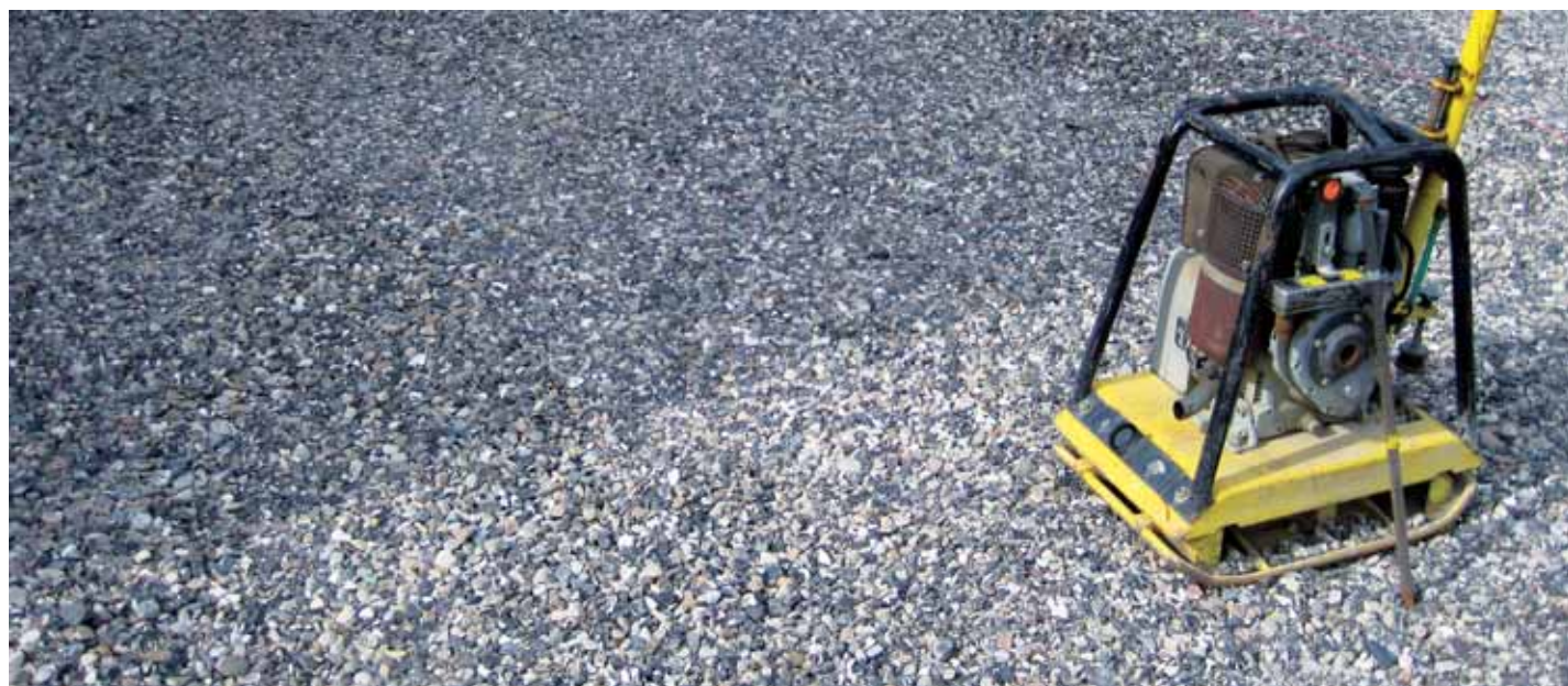
Vibrering af bærelag uden finstof og med ca. 30 % porevolumen. Foto: Søren Gleerup.
