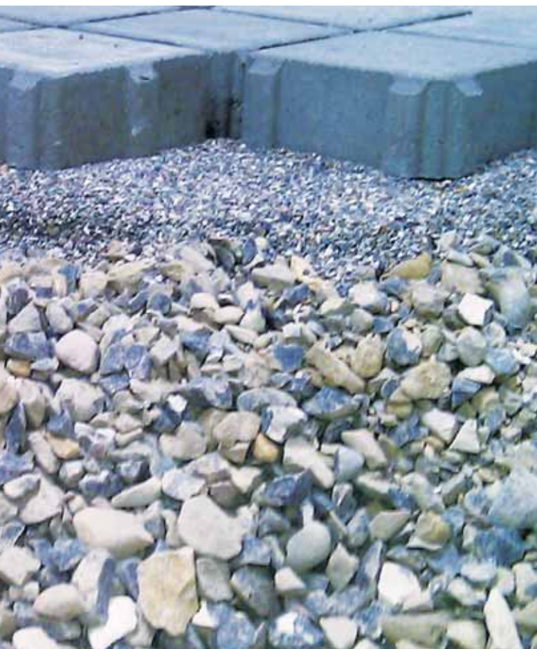
Nederst: Opbygning af permeabel befæstelse med NCC's 'DrænStabil' og 'DrænAf' afretningslag. Foto: NCC.
