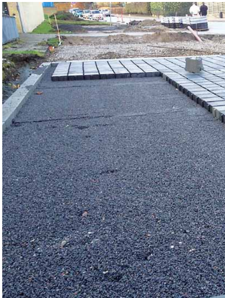
Øverste: Udlægning af sten på permeabelt underlag. Bemærk det grove afretningsmateriale. Foto: Søren Gleeurup.
