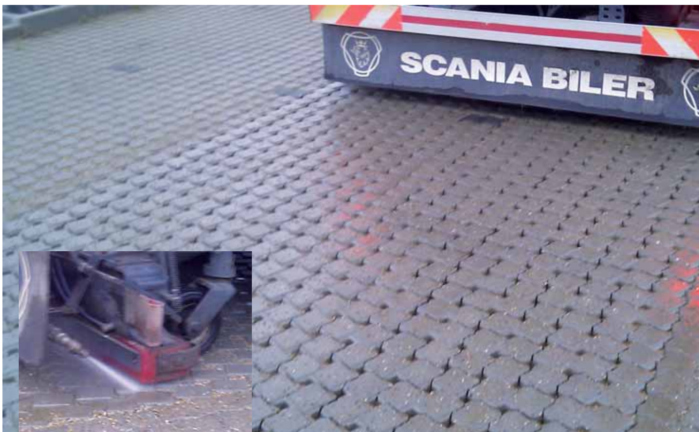
Oprensning af fuger med specialkøretøj der spuler og suger. Foto: Søren Gloorup.
