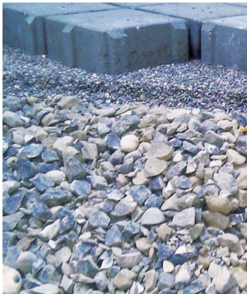
Øverste: Udlægning af sten på permeabelt underlag. Bemærk det grove afretningsmateriale. Foto: Søren Gleeurup.
