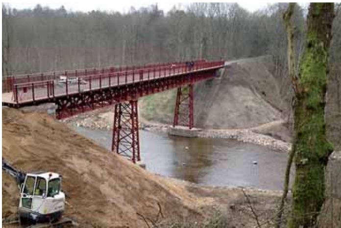
Broen er blevet frilagt - og åen har fået plads.
