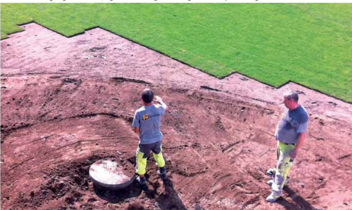
Der findes ingen maskine som kan lægge rullegræs ud i fru Hansens have. Derfor må anlægsgartnerne klare lægningen i hånden, og det kan hurtigt blive tungt. Foto: Leopold Rullegræs A/S.
