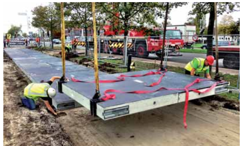
SolarRoad ved at blive indbygget i en cykelsti, Holland. solarroad.nl.
