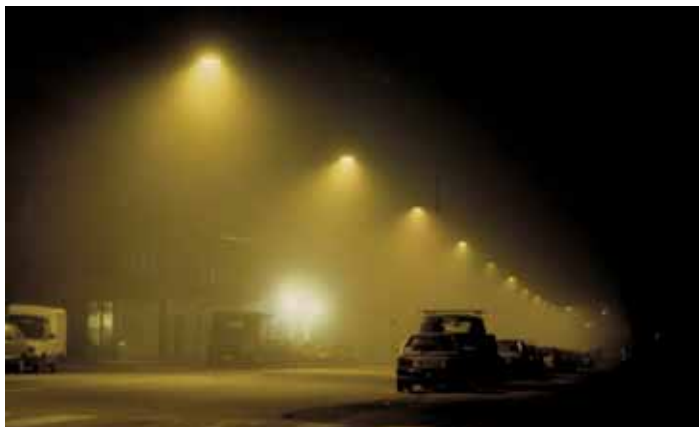
Armaturerne ('København-armaturet') er skærmede og sender det meste lys direkte ned på gaden hvor der er brug for det. Foto: P.T. Aldrich.
