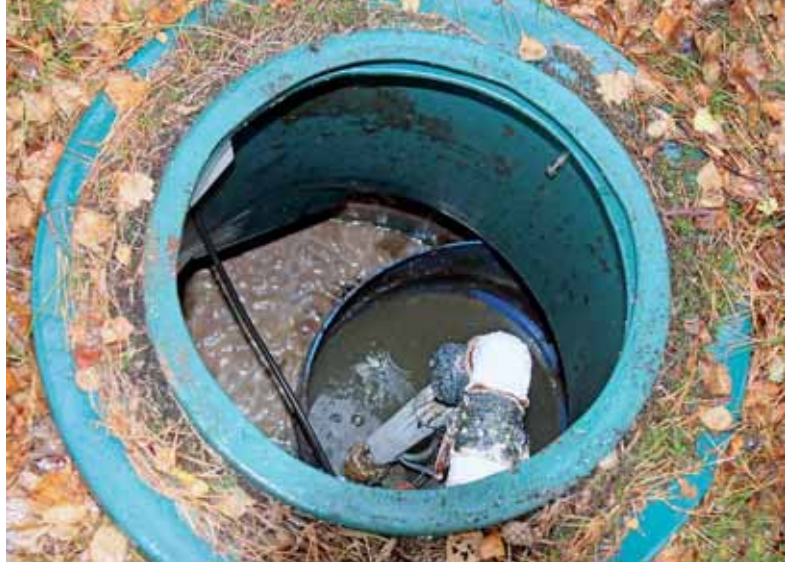
Når flydelaget i bundfældningstanken er væk, er det op til KSA-operatøren at få tanken tømt helt. Det sker langt fra altid.
