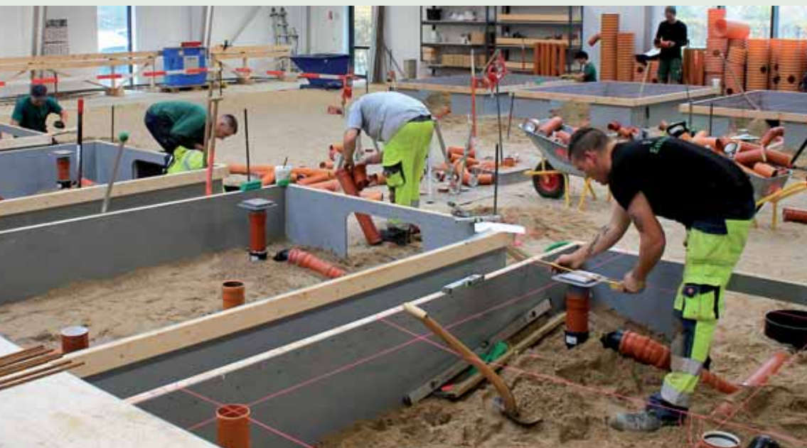
Anlægsgartnererelever er i gang med at lægge rør på Vilvorde der netop har haft de første 17 elever igennem den praktiske prøve på rørlæggeruddannelsen. Foto: Roskilde Tekniske Skole, Vilvorde.
