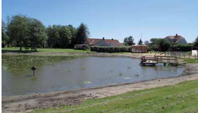
En jordført regnvandsledning fra en bebyggelse til en sø er ikke autoriseret arbejde. Billedet vedrører dog ikke den nævnte sag, men er fra det nyrestaurerede gadekær i Udbyover. Foto: Randers Kommune.
