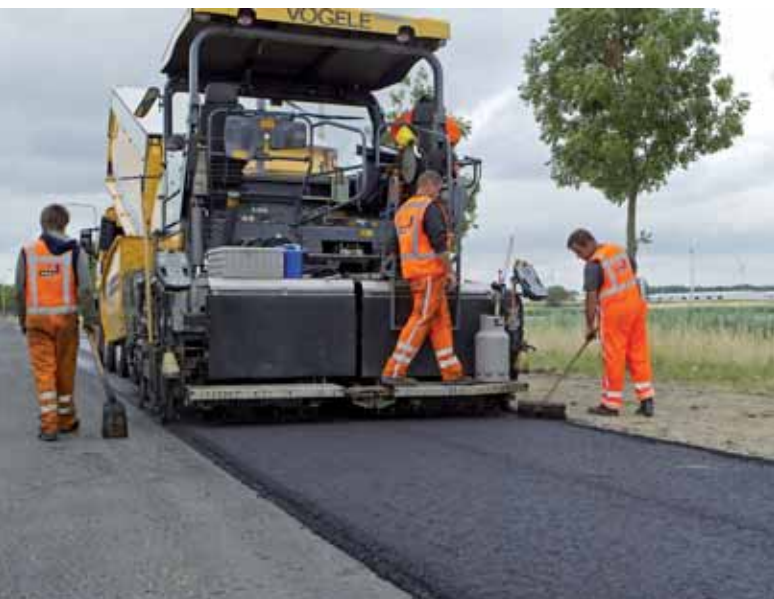
Asfalt med ligning lægges ud. Det sker på helt samme måde som med traditionel asfalt. Foto fra agro-chemistry.com.
