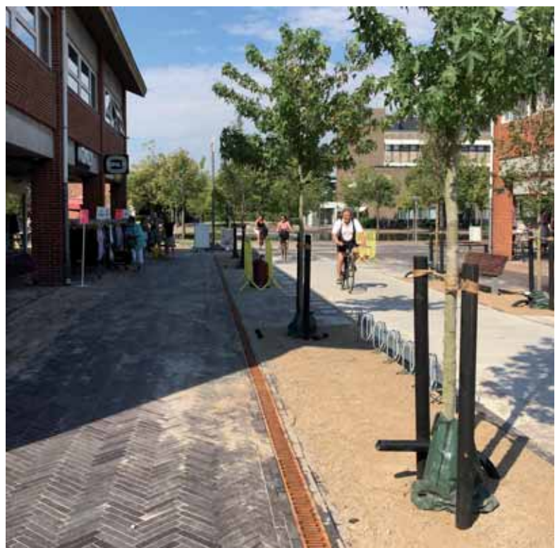
Fra renden med risten løber vandet ind i et magasin og derfra ned til et lag med plastkassetter og muld. Foto: ZoffmannHolm Landskabsarkitekter.
