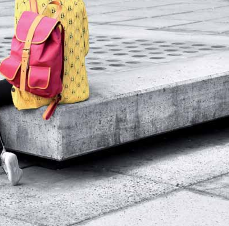
Enkeltvisse siddetrin som herover skal være mindst 50 cm høj for at bremse et køretøjsangreb. Trapper som herunder skal være 50 grader stejle og samlet set mindst 125 cm høje. Fotos: unsplash.com.
