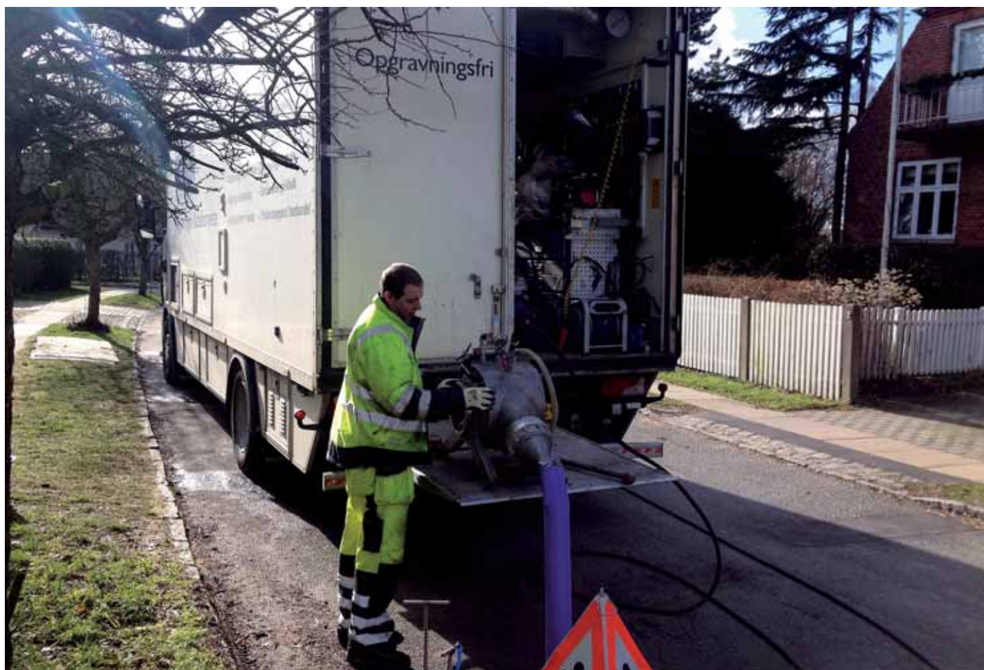
Strømpen er rullet op i den 'inversionstrømle' der står på liften. Der sættes tryk på, og strømpen krænger sig ud i kloakrøret. Foto: Sven Bech A/S.
