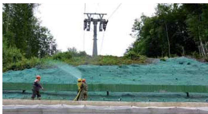
Hydrosåning på en stejl skrænt hvor der også er anvendt geonet.
