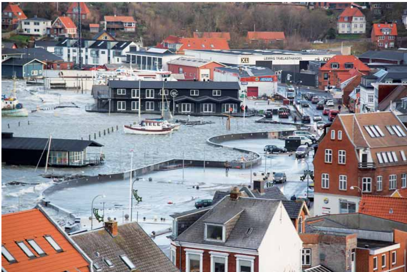
Den nye højvandssikring beskyttede Lemvigs bykerne under det rekordhøjde højvande på 1,83 meter over havoverfladen som Bodil trak med. Murens svungne forløb danner samtidig nye byrum langs havnepladsen hvor der tidligere blot var parkeringspladser. Foto: Mads Krabbe.
