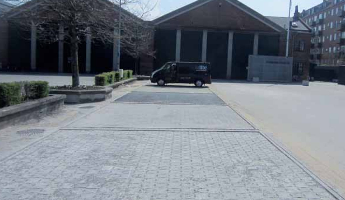
De seks forskellige permeable befæstelser ved Svanemøllehallen kort efter anlæg. Foto: Jan Støvring.
