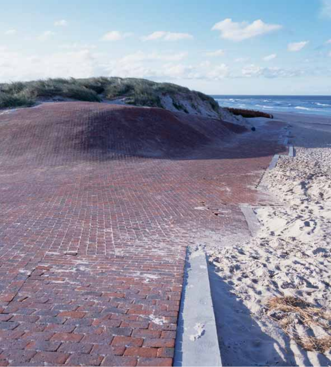
Vestled i Hvide Sande. For at holde belægningen stabil i den levende klit er den funderet med betonpæle med en betonplade oven på. Men er stormvejret kraftigt og langvarigt nok, er det hele væk. „Skræmmende og fascinerende,” ifølge Schønherr. Foto: Christina Capetillo.
