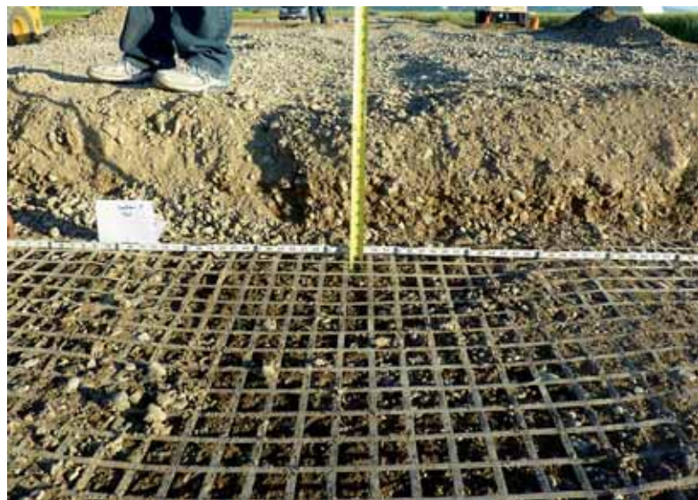
Fra feltforsøget. Et geonet indbygges oven på bundsikringen og dækkes af 30 cm komprimeret bærelag. Fra www.geosynthetica.net .
