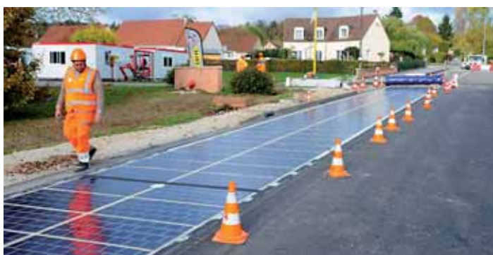
Solcellevejen anlægges. De 7 mm høje paneler lægges oven på asfalten.
