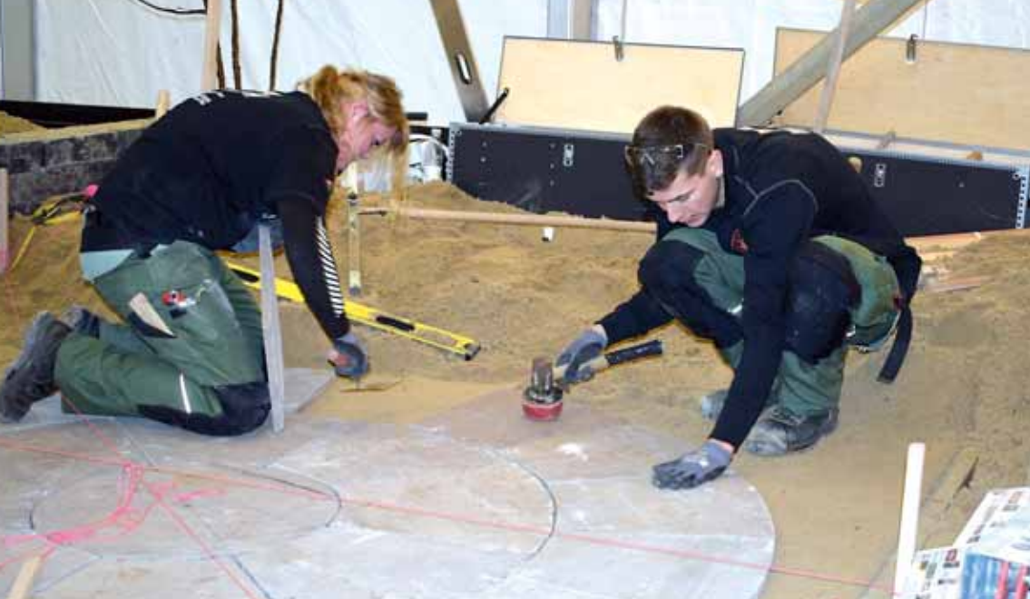
Der skal arbejdes før der kan hviles på laurbærrene. De fem hold skulle på 21 timer anlægge en 12 m 2 have med cirkelterrasse, støttemure, vandbassin, espalier og beplantning. Foto: Lotte Kristiansen.
