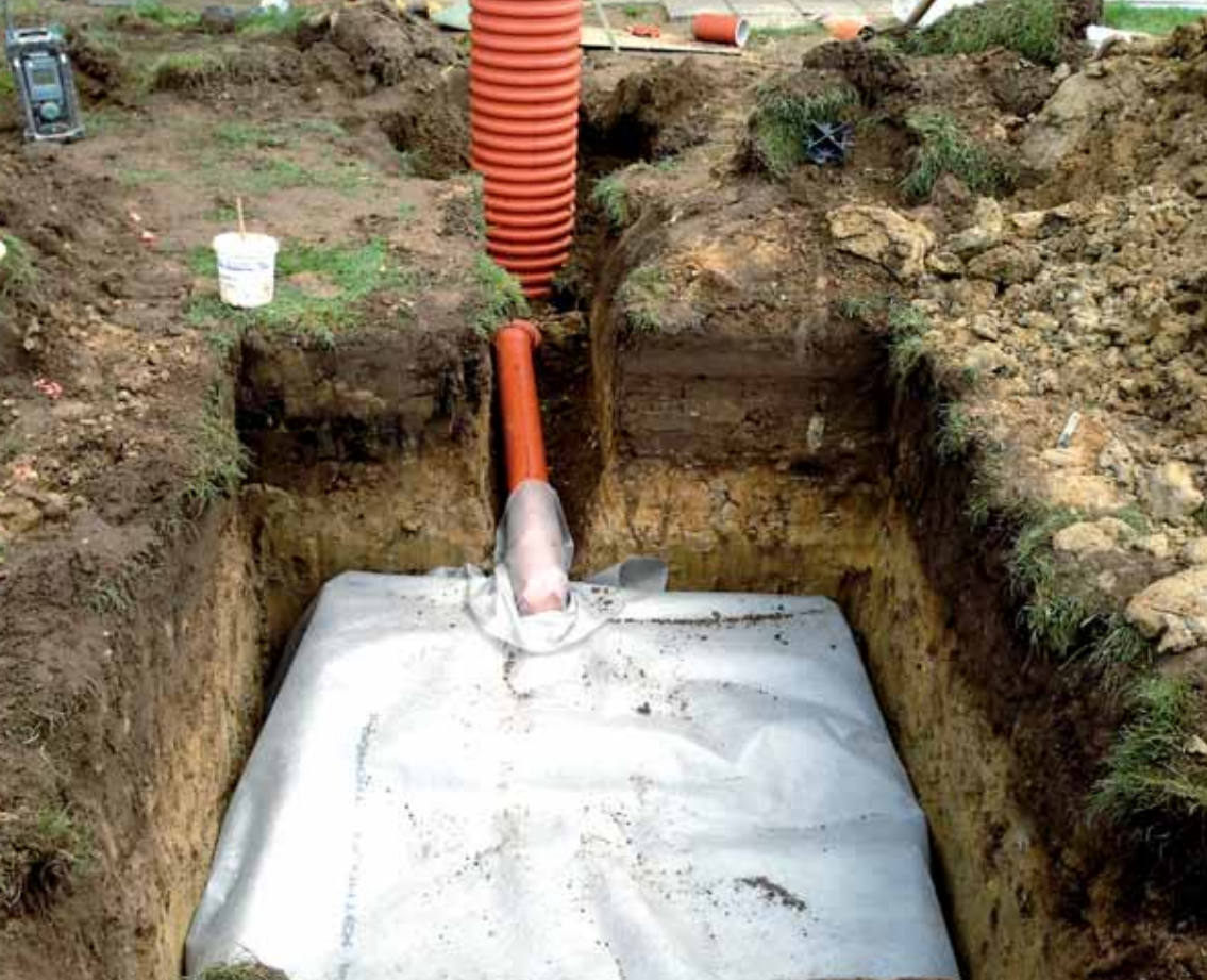
Regnvandsfaskiner er autoriseret arbejde - hvis vandet er fra underjordiske rør. Foto: Schak Anlæg & Kloak.
