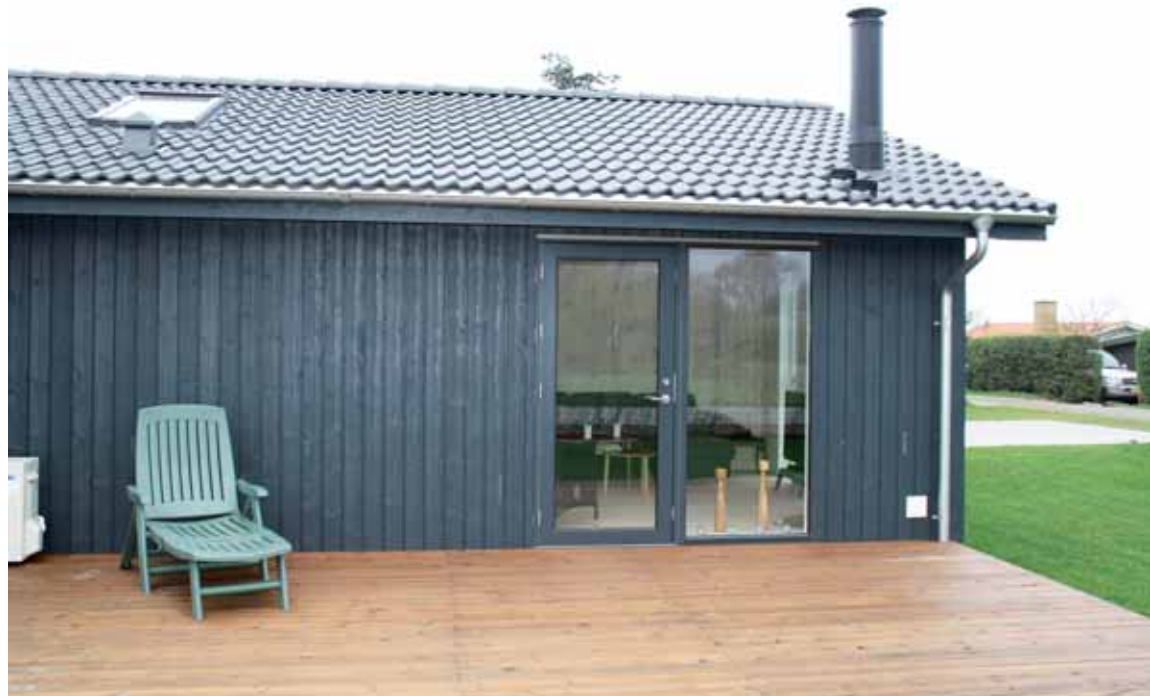
Især kravet om niveaufri adgang er problematisk, også ud til terrasser. Her er det løst helt ok. Orkidé Huse A/S.
