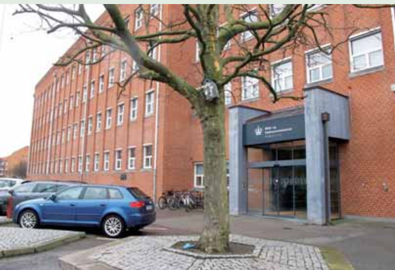
Miljøstyrelsen i Haraldsgade i København. Nu skal komplekset fraflyttes.
