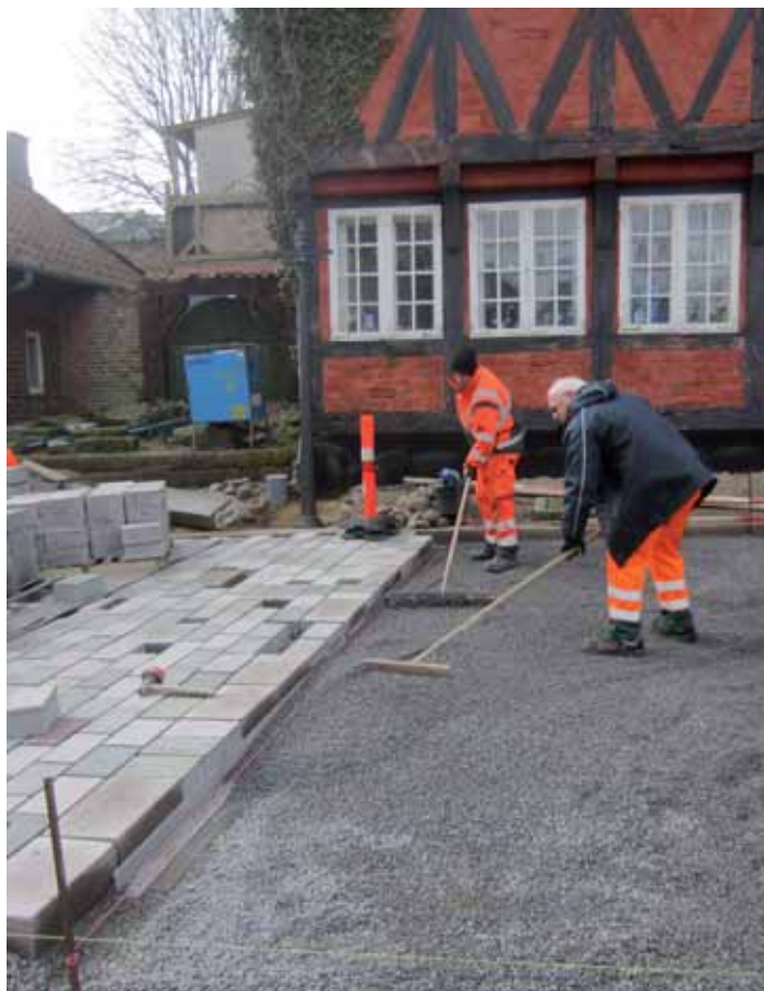
Fra anlægget af Ribe Domkirkeplads i 2011-13. Afretningslaget i den gennemtrængelige belægning består af 5-8 mm skærver der er med til at lede regnvandet hen til de nedsivningsrender som går gennem den tætte bund af stabilgrus og ned til kulturlagene under pladsen. De skal holdes fugtige for ikke at synke sammen. Foto: Jan Støvring.
