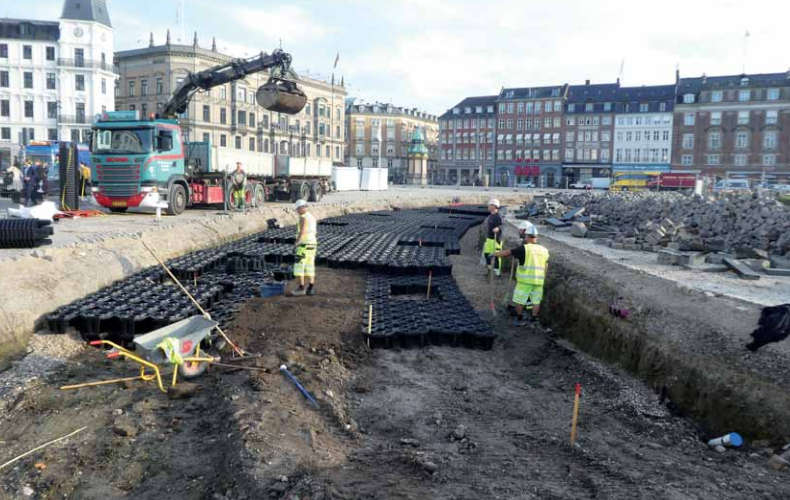
16.000 Stratacell-kassetter er ved at blive indbygget som rodvenlig befæstelse i Krinsen. Foto: Københavns Kommune, 4.9.2018.
