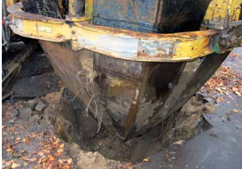
Den hydrauliske træspade er i gang med prøveopgravningen af det første testtræ fra Kongens Nytorv. Foto: Miljøpunkt Nørrebro.
