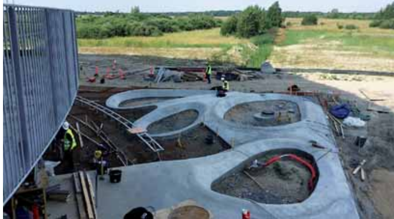
Øverst: Betonbølgerne under anlæg.
