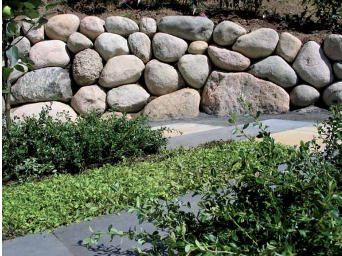
Tilsynet lettes når arbejdet er beskrevet godt. Her kan fotos gøre underværker, f.eks. for at vise hvordan en kampestenmur skal se ud. Foto: Kim Tang.
