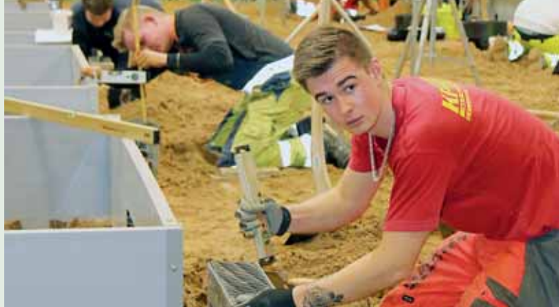
DM i Kloakarbejde med sølvvinderen Thomas Rasmussen i forgrunden.
