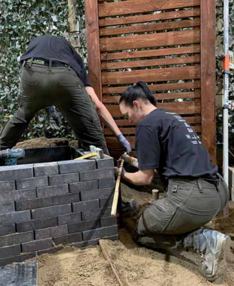
• Jakob Peter Bankel og Lærke Rose Kvisgaard fra Roskilde Tekniske Skole er i gang på deres stand. Den skrå støttemur hørte til blandt de vanskeligere dele af anlægget. Foto: Julie Thostrop Vestergaard.
