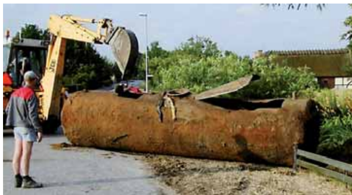
Tankoptagning på Skellerup Bygade 41, Fyn i 2003. Foto: Miljøstyrelsen.
