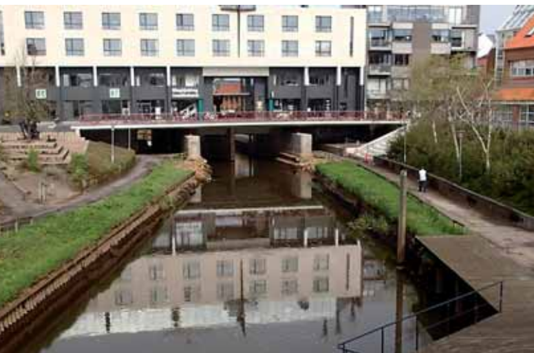
Holstebro før og under oversvømmelsen i 2015. Holstebro er et af de steder som er allermest truet af vandet fra landet. Med Storåen store opland batter små løsninger ikke. I stedet arbejder forsyning og kommune for tiden sammen om et stortilet dæmningsprojekt som skal kunne lukke når behovet kommer hvert 5.-7. år.
