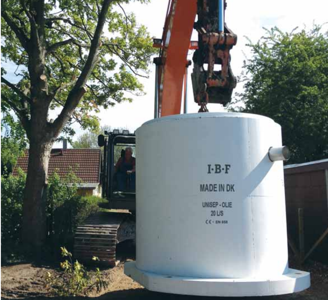
Unisep Olie- og benzinudskiller fra IBF til 'mindre oliemængder'. Den skal forsynes med automatisk flydelukke der lukker udløbet når olielageret er fyldt samt en alarm der advarer når det er ved at ske. Udskilleren er testet efter DS/EN 858-1. Udskillerne leveres med kapaciteter fra 3 til 50 liter pr. sekund og med integreret sandfang.
