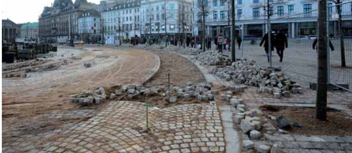
Chausséstenene på Kongens Nytorv er sat om, nu med ru underside der giver større friktion med underlaget.
