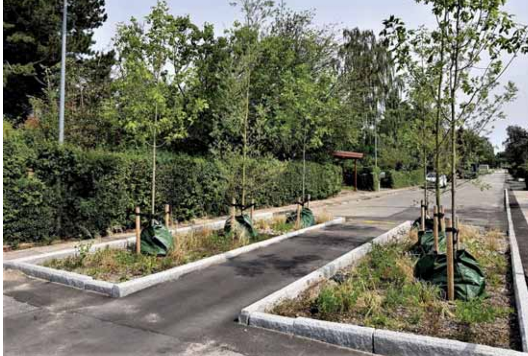
Projekt hvor der er anvendt RodVækst, et specialfremstillet, rodvenligt bærelag fra BG Byggros med pimpsten som bærende element og med dokumenteret bæreevne.
