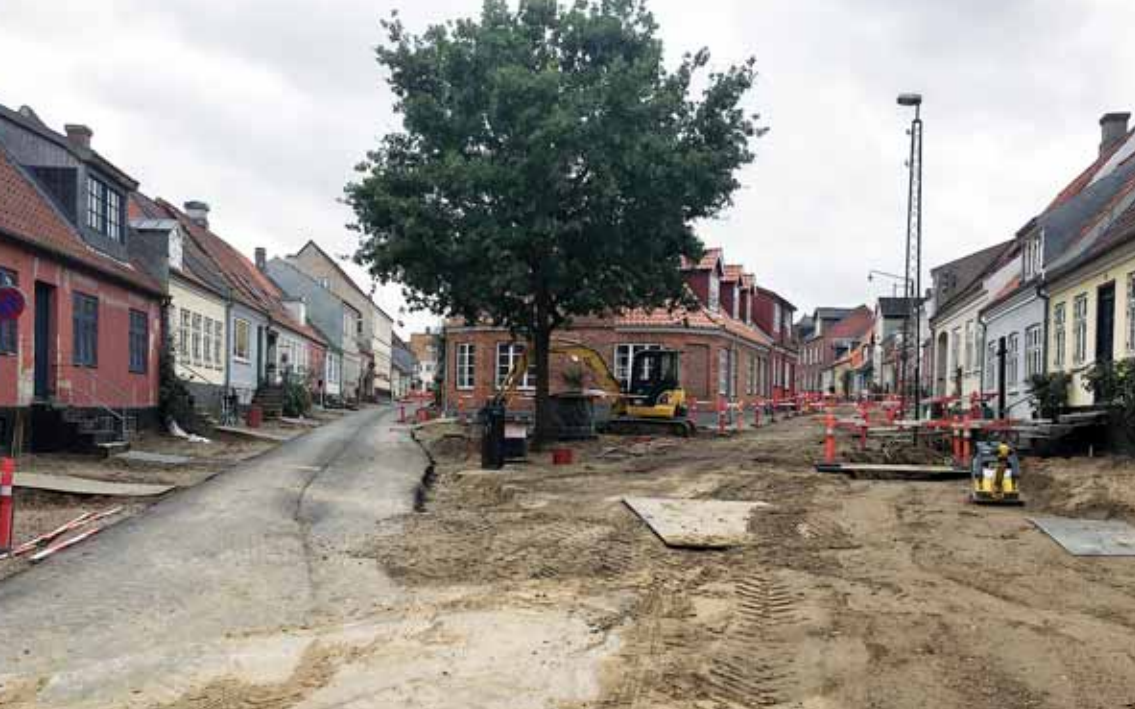
Fra projektet Klimabyen Middelfart hvor grus så vidt muligt blev genbrugt. I den ældre del af byen blev gadernes profil omlagt fra at have pilhøjde til at danne et trug. Foto: InnoByg.
