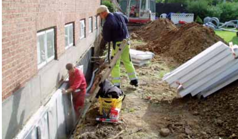
Etablering af omfangsdrænen. Foto: Helge Hansen Hørve ApS. hhhaps.dk.
