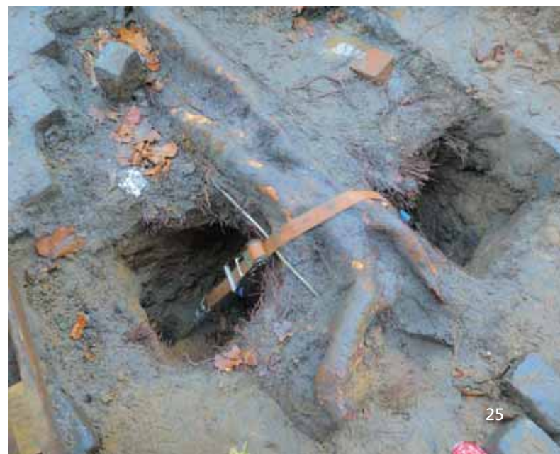
Figur 6: Roden, ankerhullerne og stroppen som fastholder roden.
