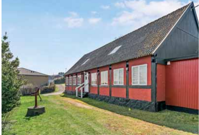
Januar 2020, før istandsættelsen begynder. Huset ser idyllisk ud, men er i ringe forfatning. Foto: Lærlingenehus.dk.
