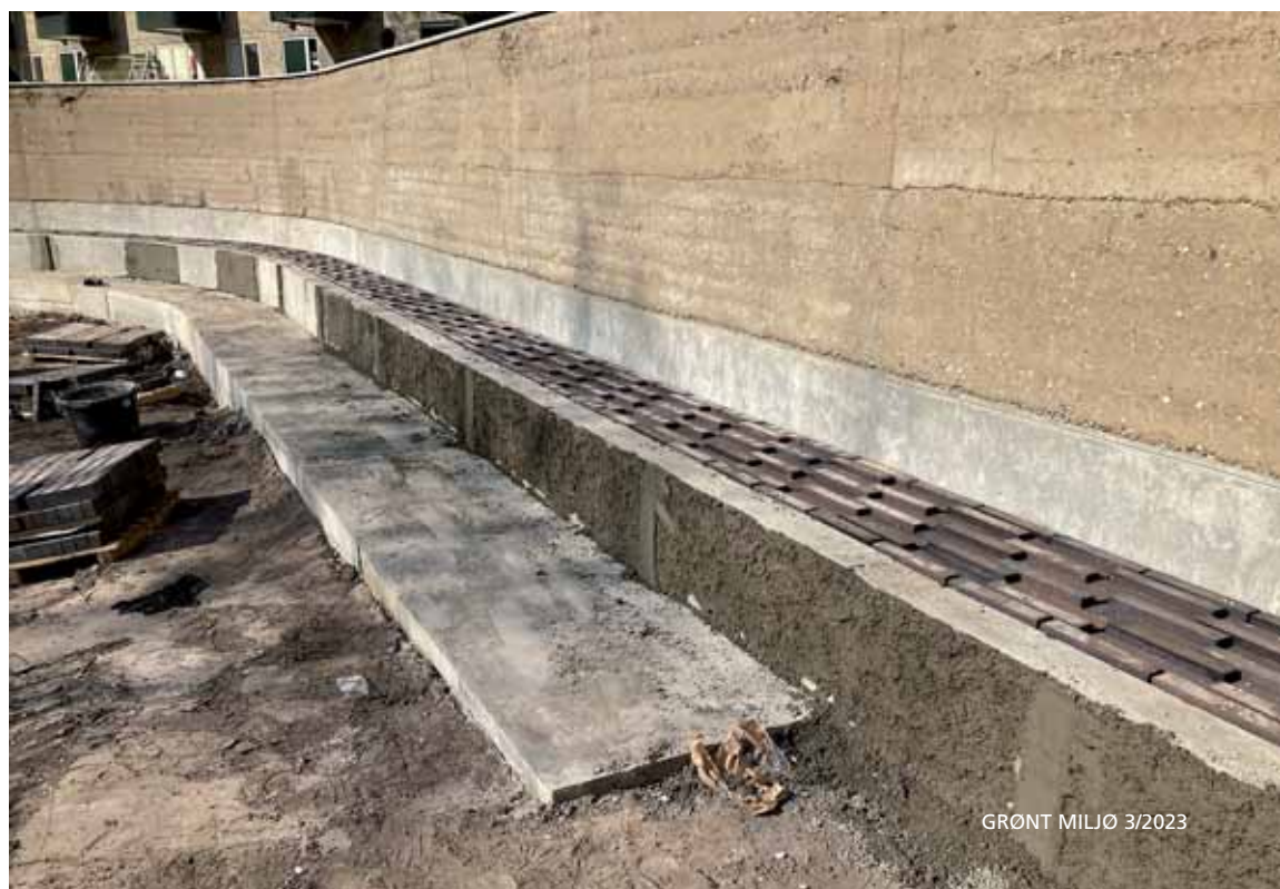
• Et af projekterne i 'Genanvendelse af overskudsjord og betonaffald lokalt' er Fremtidens Gårdhave i en boligkarre i København. Her er der bl.a. indbygget en 'morænemur' af jord og en vandtrappe der tilsammen løser en række klimatilpasningsproblemer. Foto: SLA.
