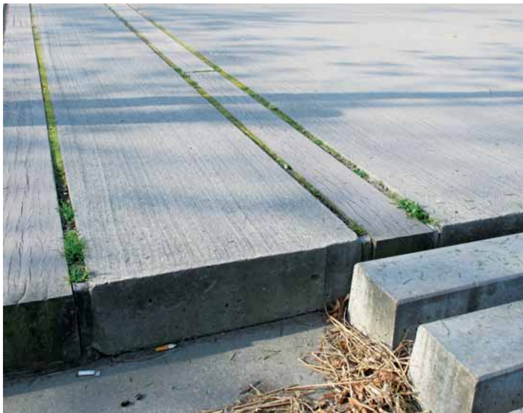
Støbefelterne på CBS-stien er på den ene led 7,7 meter - hele stien bredde. På den anden led er de mest 4-5 meter, men kan som her også være smallere. Støbeskellene er 15 cm brede og opfyldes af en azobeplanke med 25 mm grusfyldte fuger på hver side. I stiens ene side er der en rendesten.
