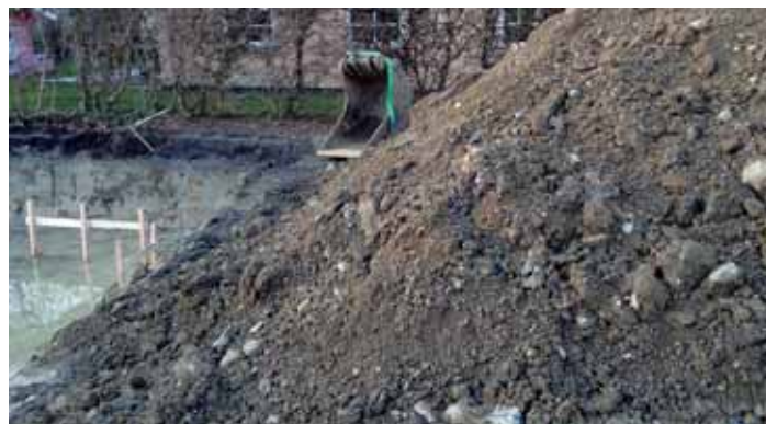
Byggeri og anlæg skaber overskudsjord - som skal ud at køre.
