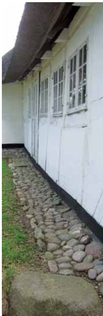
Pigstensbelægning under tagskægget. Foto: Søren Vadstrup.
