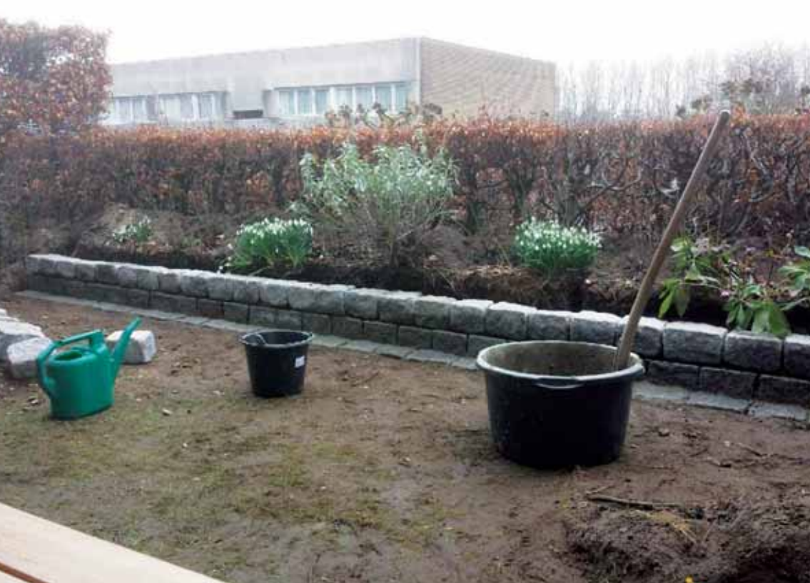
Støttemuren, her oppe i to skifter, stod lidt skævt i forhold til terrassen i forgrunden. Men hvad var der aftalt?
