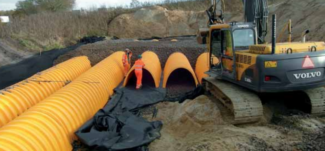
De parabelformede faskiner af PP-plast er ved at blive indbygget i et tidligere projekt. Foto: Milford.
