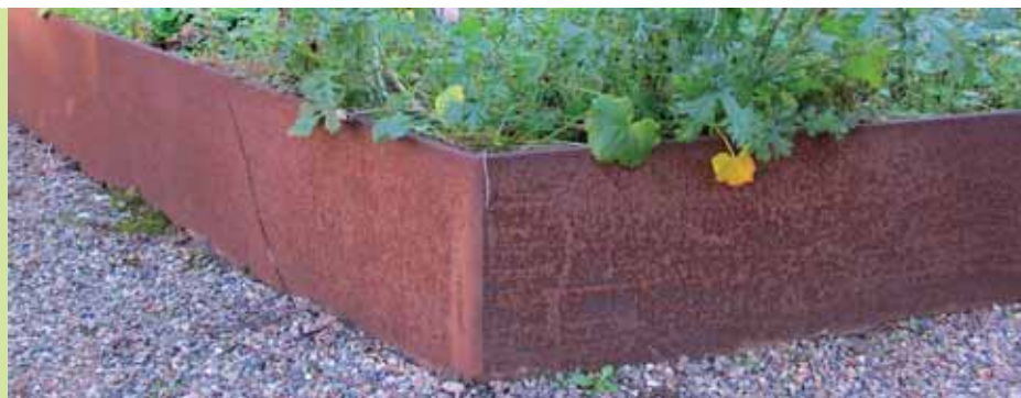
Cortenstål brugt som støttemur. Men hvis stålet ikke kan tørre, er rustbeskyttelsen så som så.
