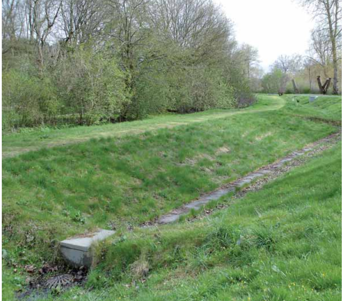
FORSINKELSE OG RENSNING. Vejvandet fra Harborøvej/Krogebjerg ledes via et rør ind i en eksisterende grøft i Krogebjergparken. I første del af grøften forsinkes vandet, og i næste del renses det i et dobbeltporøst filter (billedet). Vandet ledes herefter ud i Harrestrup Å der løber gennem parken. Foto: Tilde Tvedt.
