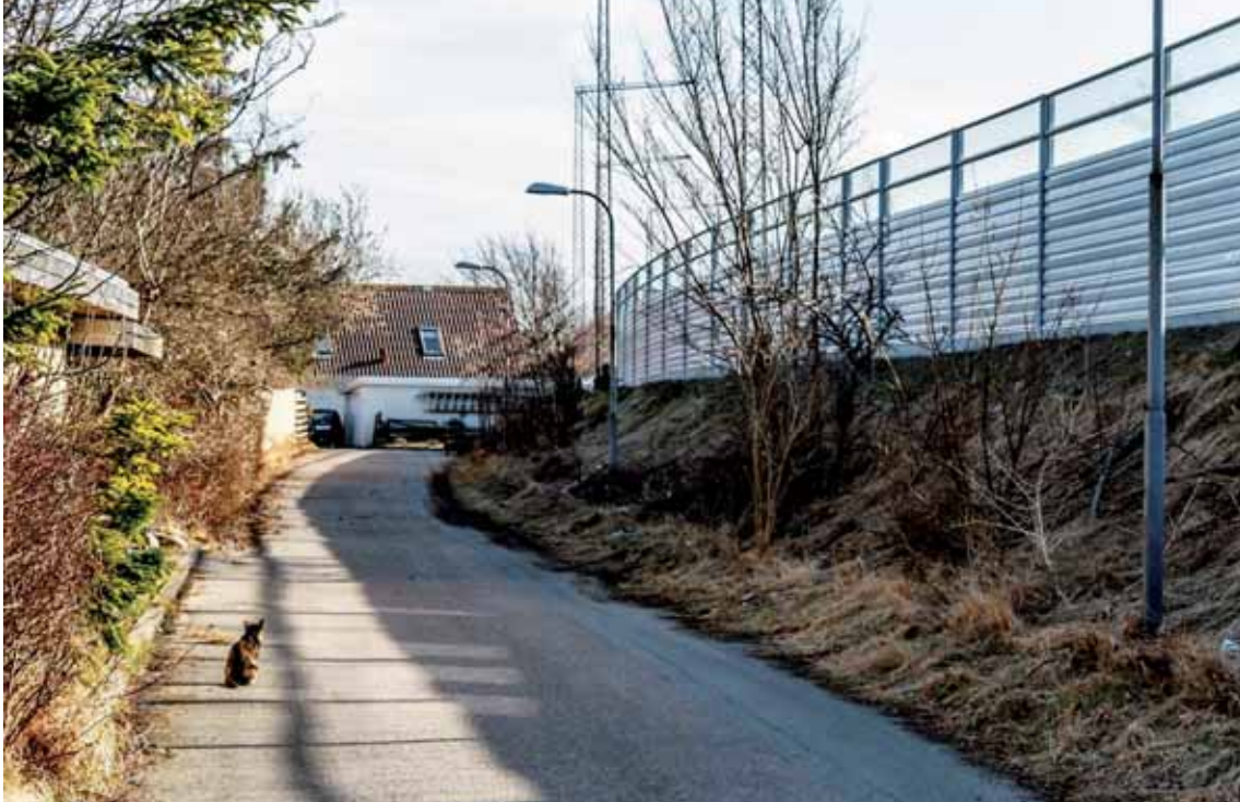
Skyggekast kan begrænses ved brug af transparente elementer. Her får katten glæde af aftensolen fordi støjskærmens øverste meter er transparent. Europavej E45, Frederikshavn. Foto fra vejledningerne.
