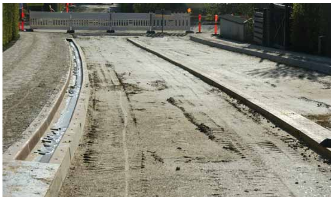
Vejkassen i Låsby bygges op med en overdækket kanal til vejvand i midten og én til kildevand i den ene side.
