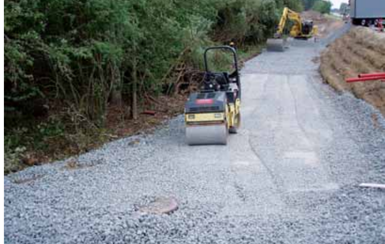
Durapor-laget er ved at blive indbygget i Ballerup. Foto: Vejdirektoratet.
