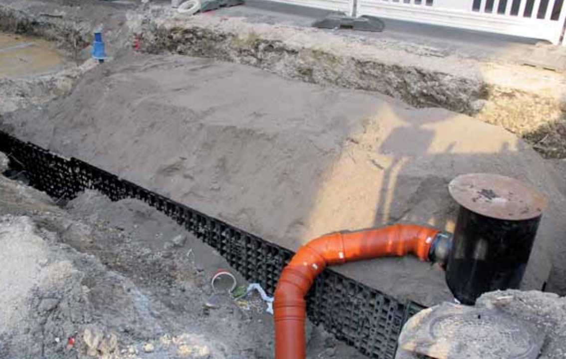
Tree Boxen (det sorte plastgitter) - er indbygget og har midlertidigt fået et læs supermuld overpå. Til højre er overløbet til kloakken etableret. Det blå rør til venstre er stophanen. Bedet bliver forsynet med regnvand fra samme brønd hvor der også er overløb til kloak.
