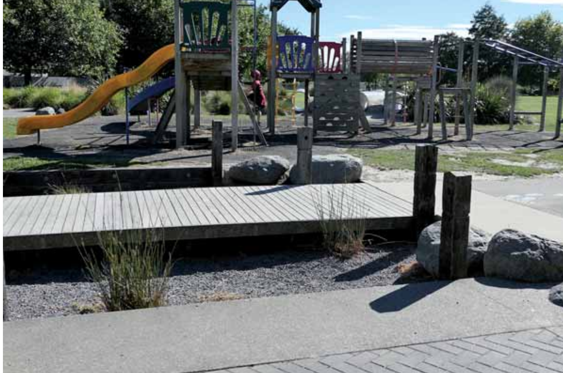
Et regnvandsbed til opsamling af regnvand fra skolens tag benyttes også i klimaundervisningen.
