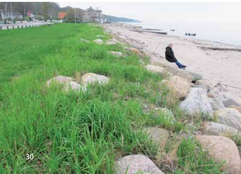
Stenkastningen er her afdækket af tangkompost og ral udlagt lagvist.
