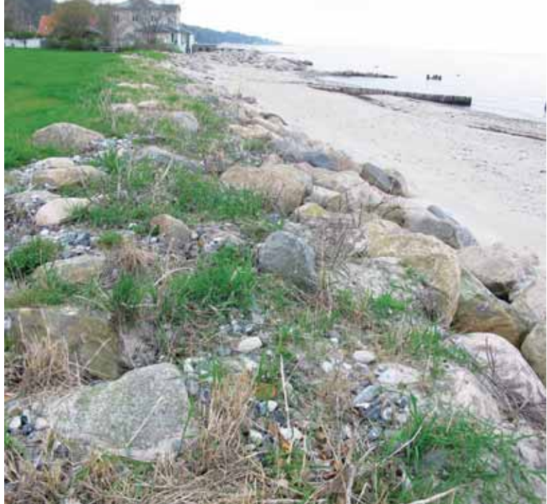
Stenkastningen er mættet med frisk tang og afdækket med et lag ral.
