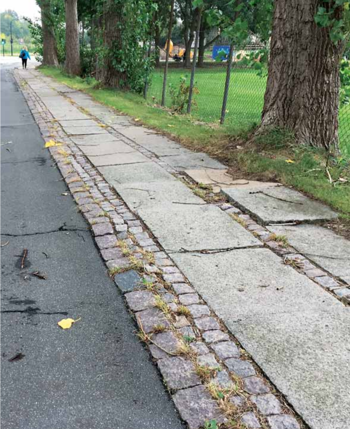
Poppeltræets rødder vokser ind under fortovet og videre ud i cykelstien. Bulerne i fliser og asfalt er ikke længere forsvarligt. Et udbredt problem mange kender til. Foto: Benedicte I. Dyekjær.
