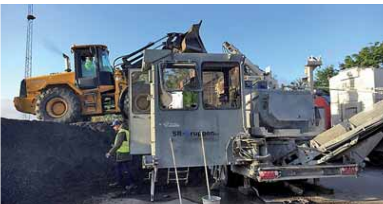
SR-Gruppen kan mikse op til 220 ton BSM i timen direkte på arbejdsstedet med det mobile KMA-anlæg. Foto: SR-Gruppen.
