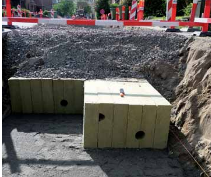
Rockflow indbygges som faskine under kommende vej. Foto: Lapinus.
