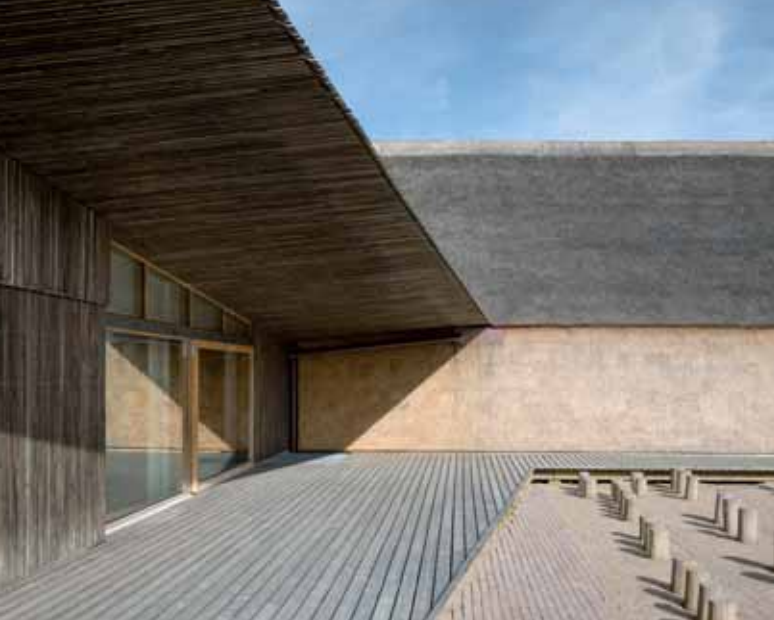
Boardwalken fører rundt i museets udemiljø. Brædderne er ThermoWood, varmebehandlet fyrretræ. Foto: Adam Mørk.
