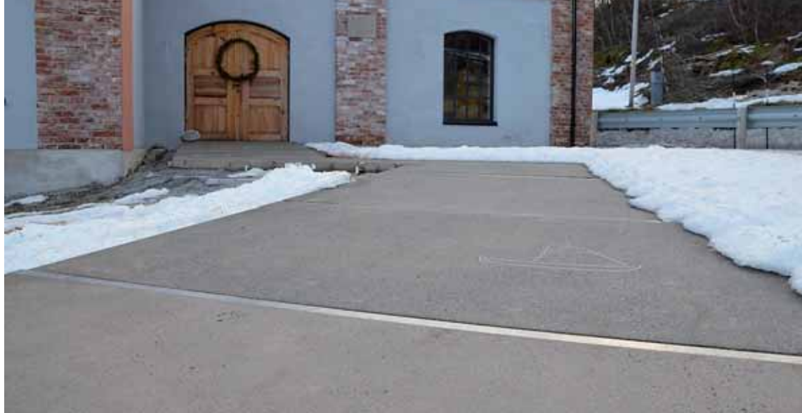
Fliser af lerholdig beton og armeringsnet af aluminium. Billedet er fra 14. marts. Foto: Jonathan Kalvik.
