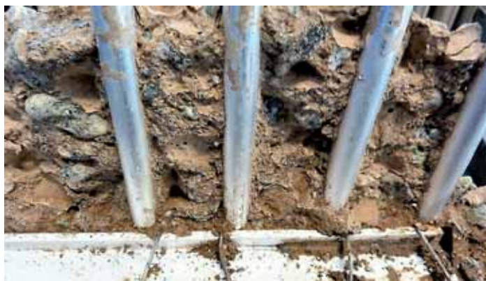
Betonarmering med aluminium uden tegn på korrosion i en af testene i Dare2c-projektet. Foto: Harald Justnes.
