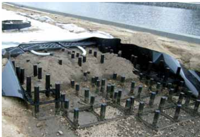
En trægrube bygget op af 'Silvacells' i to lag. Foto: CROW.
