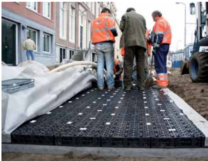
En trægrube af 'Amsterdam Tree Soil' med trykfordelende, åben plastplade oven på. Foto: CROW.
