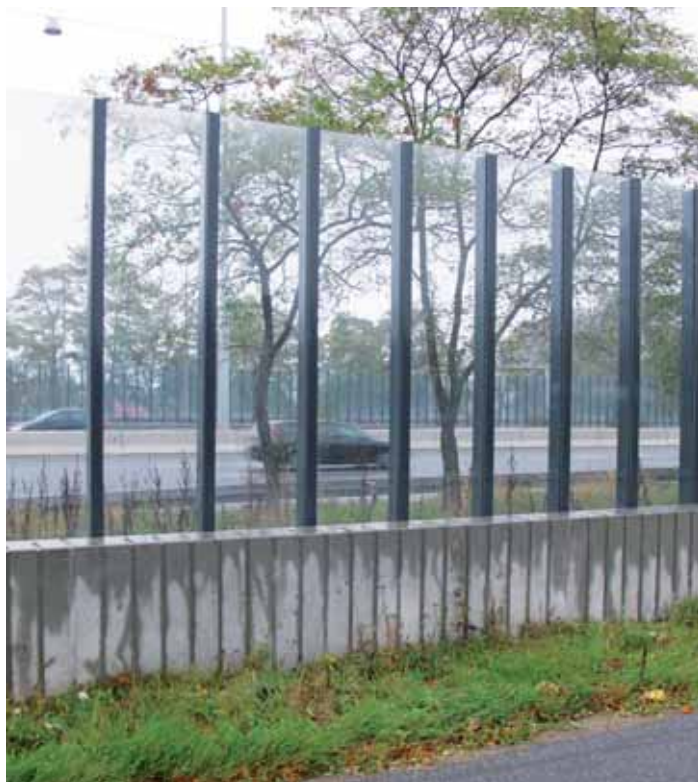
Dæmpningen er cirka 2 dB pr. meter effektiv skærmhøjde.
