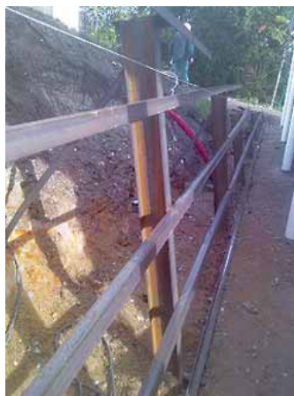
De kraftige I-jern på 140x140 mm er banket i jorden. Her hvor muren er op til 2½ meter høj er der påsvejset 50x50 mm vinkeljern som strøer. Pladerne svejses bagefter på strøerne. Foto: Anders Matthiessen.
