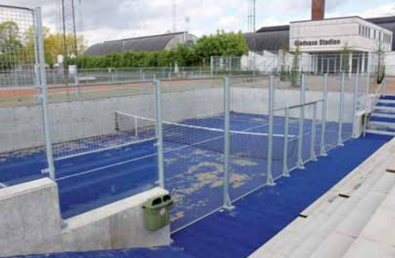
Paddletennisbane som forsinkelsesbassin. Paddletennis er en mellemting mellem squash og tennis med et spilleareal på 10x20 meter. Bunden er her blå kunstgræs. Bunden skråner lidt, så vandet løber ud af en afdræningsrende i den lave side.
