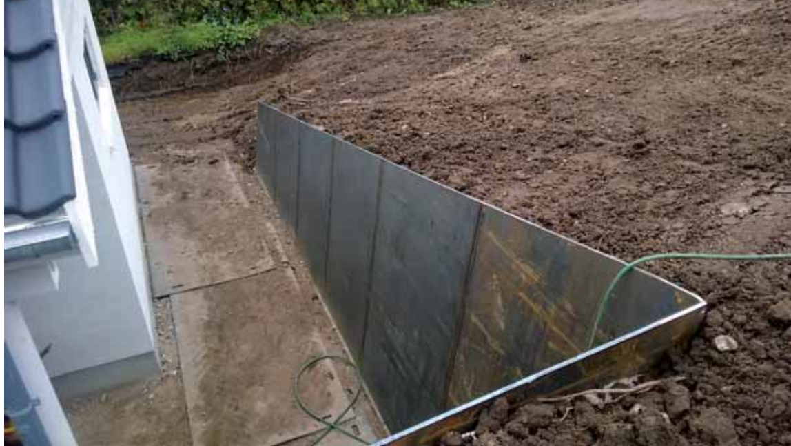
Støttemur af sort ubehandlet stål. Pladerne er 1250x2500 og 1000x2000 mm. Foto: Anders Matthiessen.
