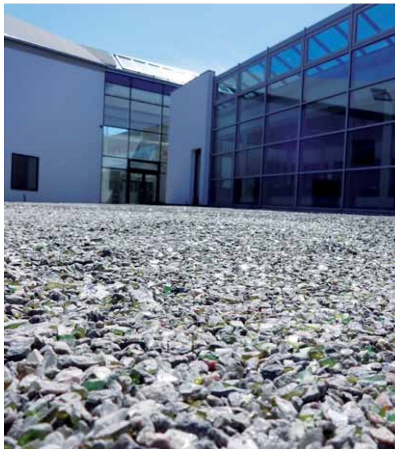
Overfladebehandling med et tilslag i overfladen af 50% glaskorn. Glasret reflekterer lyset fra solen og lysarmaturer.
