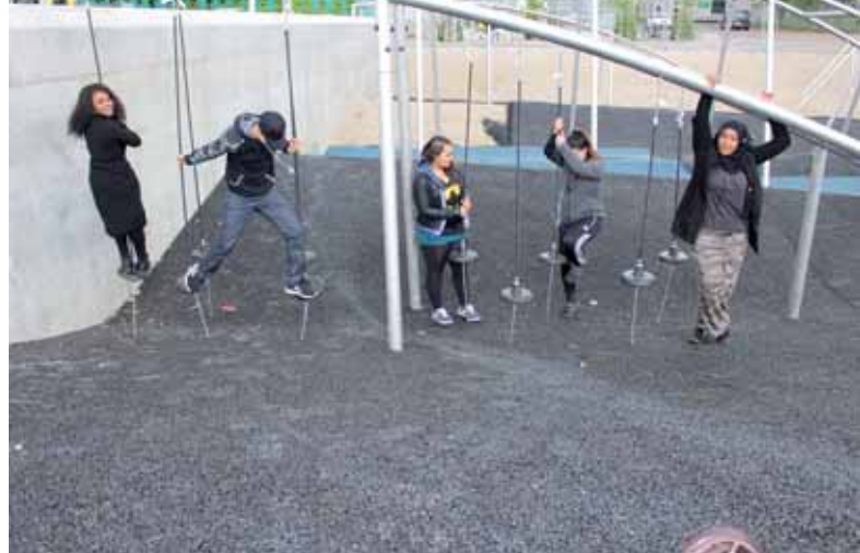
Forsinkelsesbassin med en bølget bund af gummibelægning og redskaber til bevægelses- og styrketræning. Vandet kan sive ned gennem den permeable gummibelægning, men det meste løber ud gennem udløb i bunden og - forsinket - videre i byens regnvandssystem.
