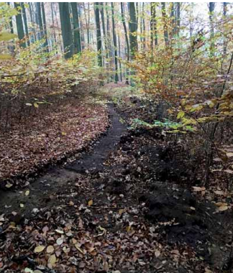
Først skræbes en rende til sporet i den ønskede bredde. Derefter lægges stabilgruset ud med dumper, afrettes og pladevibreres. Derefter er mountainbikesporet i princippet klar til brug, men der kan også lægges et top lag af lergrus på, bl.a. for æstetisk at gøre sporet mindre tydeligt for de andre skovgæster. Foto: Mads Aarsdal, Sven Bech A/S.
