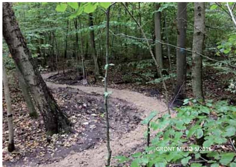
Først skræbes en rende til sporet i den ønskede bredde. Derefter lægges stabilgruset ud med dumper, afrettes og pladevibreres. Derefter er mountainbikesporet i princippet klar til brug, men der kan også lægges et top lag af lergrus på, bl.a. for æstetisk at gøre sporet mindre tydeligt for de andre skovgæster. Foto: Mads Aarsdal, Sven Bech A/S.
