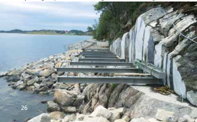
Hylder og stålprofiler til en udkraget bro. Foto: Stavanger Kommune.
