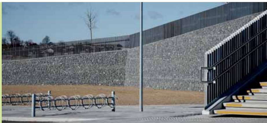
Ramperne til Hærvejsbroen i Viborg består af op til 4,2 meter høje gabbioner med kerne af jord og grus. Foto: Perfekta PR.
