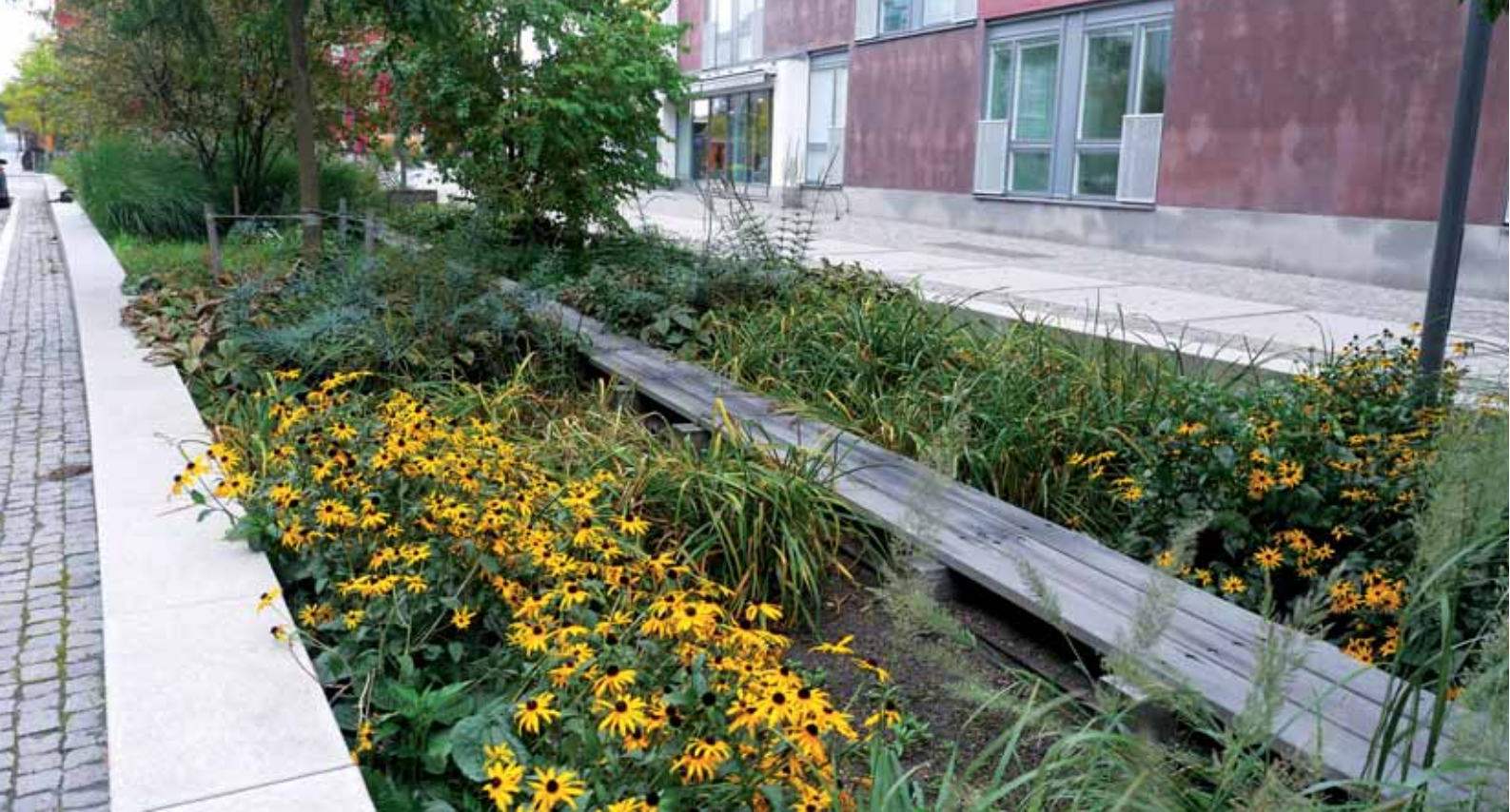
Regnbæd med biokul i Hjorthagen, Stockholm. Biokullet kan forbedre de rå forhold som mange planter i urbane miljøer lever under, bl.a. ved at forbedre vand- og næringsforsyningen. Foto: Jonatan Malmberg.
