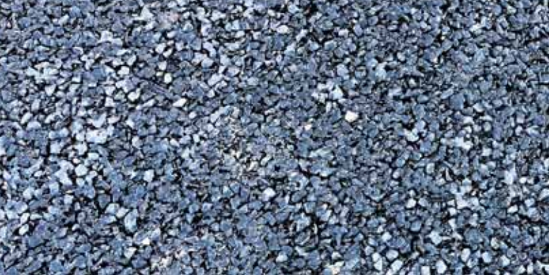
Drænasfalt med åben overflade på Toftevej. Foto: Colas Danmark.
