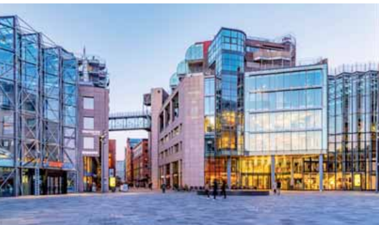
Bryggetorget i Oslo er et eksempel på et moderne byrum der er indgået i undersøgelsen. Bygningerne er asymmetriske, uden ornamentation og er opført af materialer som glas, stål og beton. Photo: Shutterstock.
