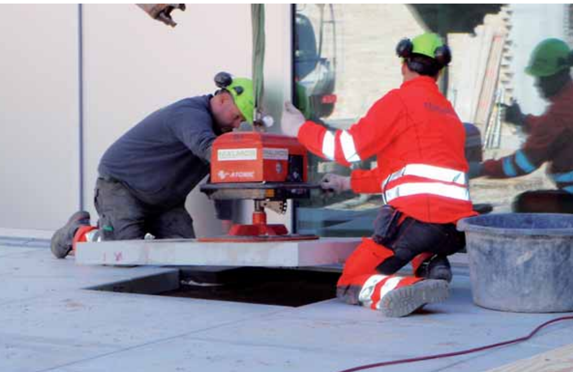
Malmos A/S bruger vacuumløfter til store fliser på Det Psykiatriske Hospital i Slagelse. Foto: B. Mortensen.
