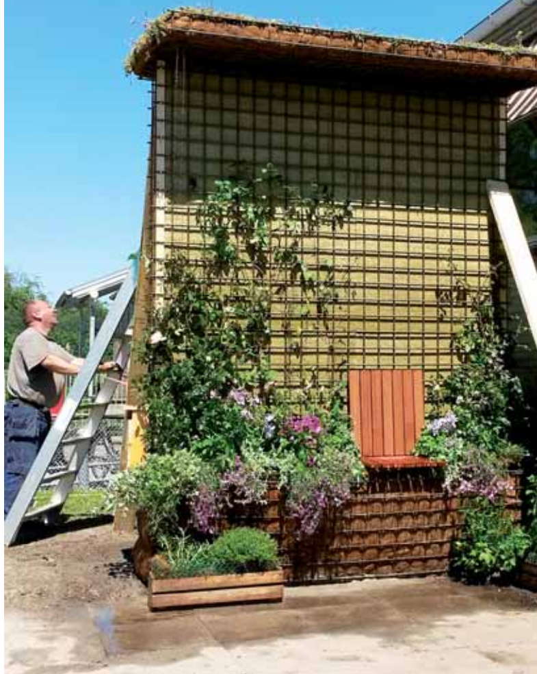
Model af en grøn gabion. Den er bygget op af tre elementer og kan tage et parcelhus' tagvand, mens bundelementets 80 cm vækstlag giver mulighed for en varieret beplantning.
