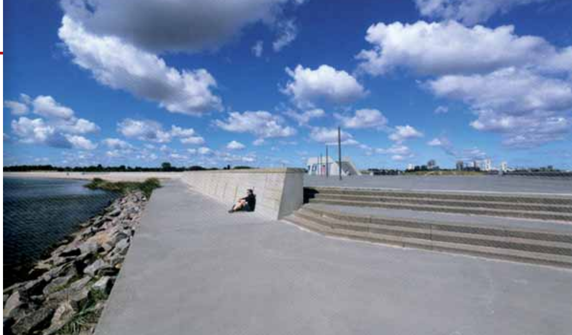
Et af bogens eksempler: Amager Strandpark hvor både belægninger og kantelementer er insitu-støbt beton.
