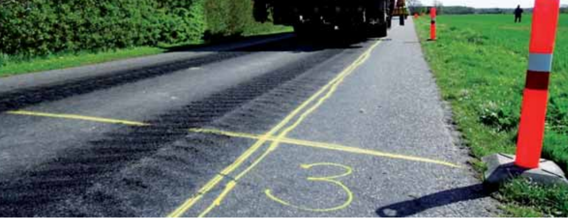
Ribbedæk og bælte forårsagede indtryksmærker og gennemsvedninger i OB'en. Foto fra rapporten.
