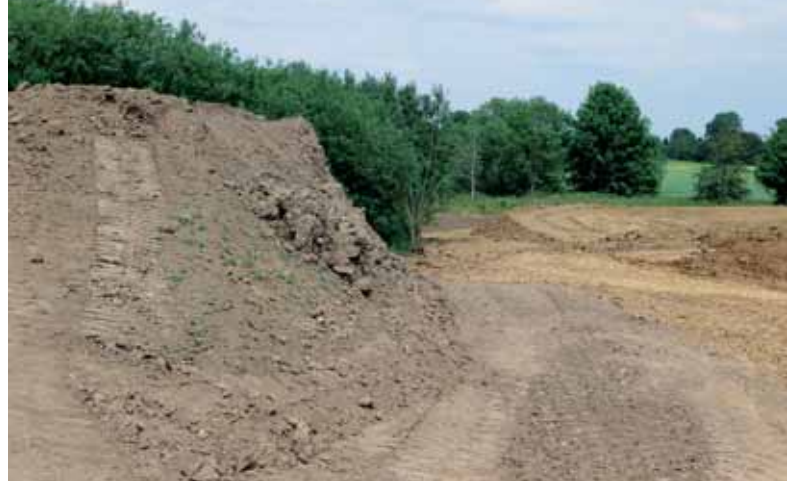
En forudsætning for at kunne genbruge den eksisterende jord er god plads til at sortere og oplagre jorden og luft i tidsplanen. Her jorddepot og anlæg af bassinkanter i Køge Nord.
