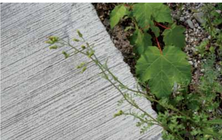
Store betonfliser med børstet overflade danner gangarealer langs bygningerne. Foto: Tilde Tvedt
