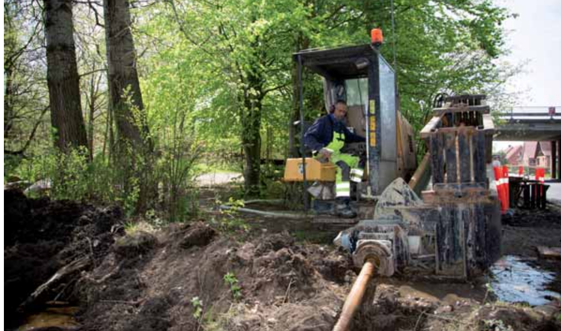
En styret underboring af de de større - under Tange Sø. www.danboring.dk .
