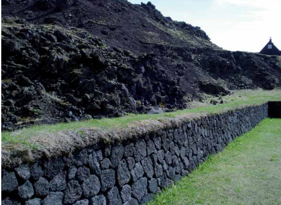
Støttemuren er en klassisk anlægsgartnerdisciplin, især på Island hvor der er masser af højdeforskelle og klipper. Her ses en traditionel lavastenmur, der står ved en stavkirke på Vestmannaøerne ved Islands sydkyst. Foto: Torkell Gunnarsson.
